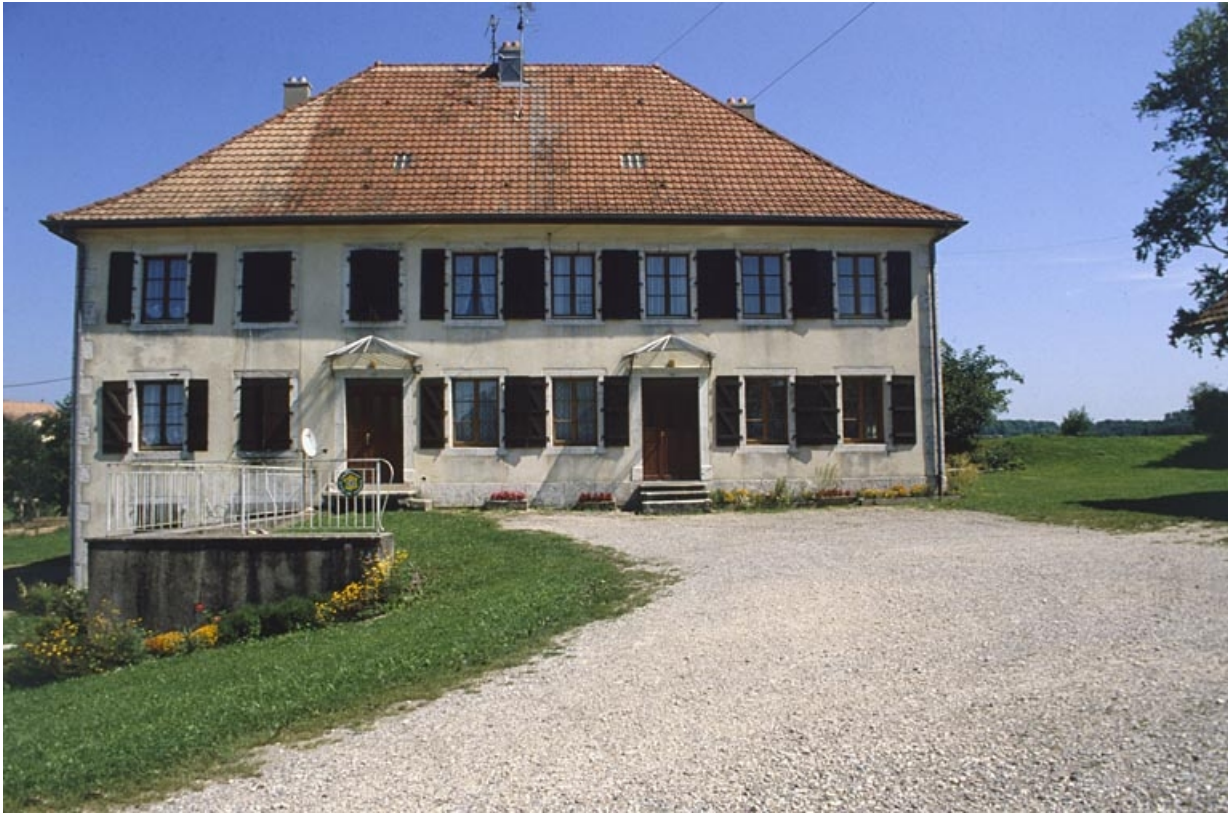
Façade ouest du logement patronal.
