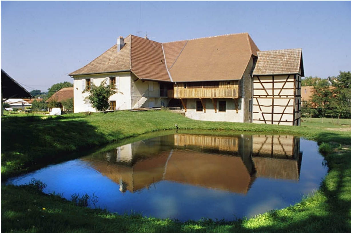
Façades postérieures du moulin.
