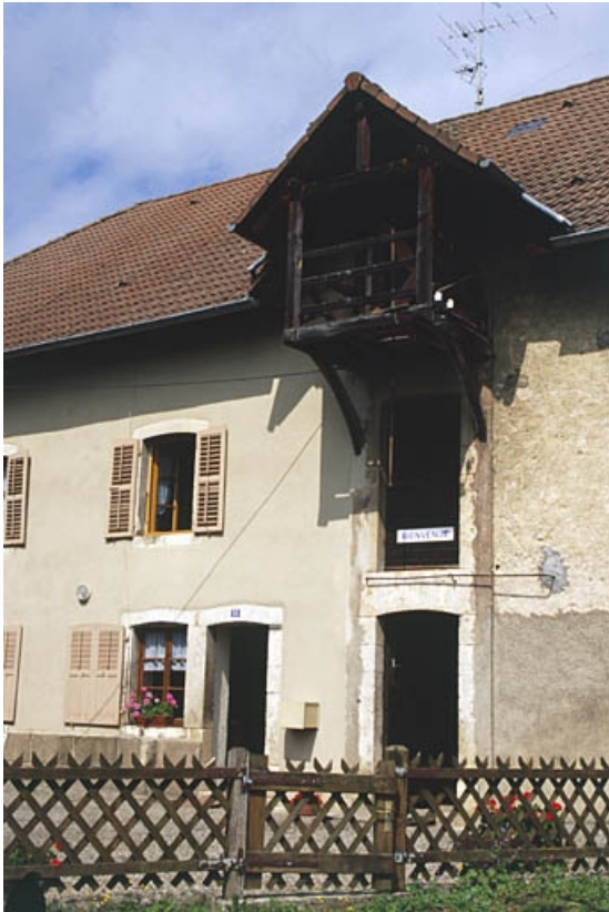
Logement accolé à la minoterie.
