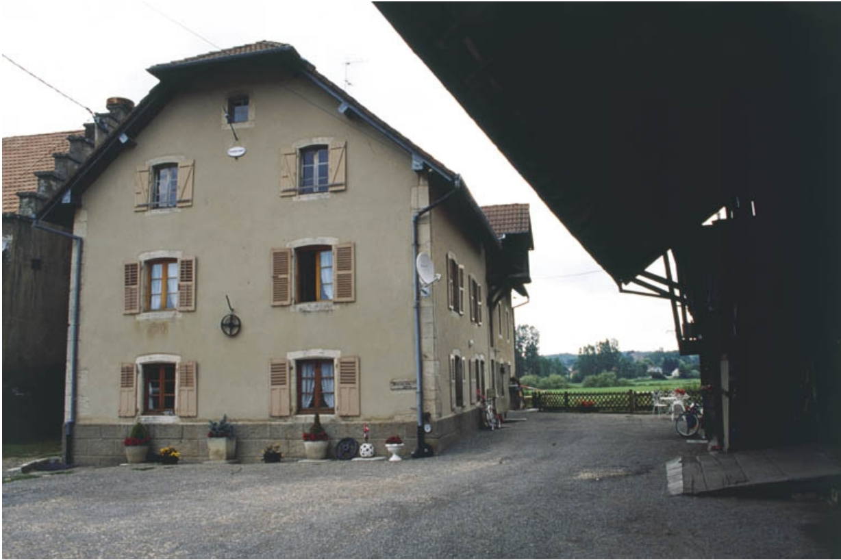
La minoterie et son logement depuis l'ouest.
