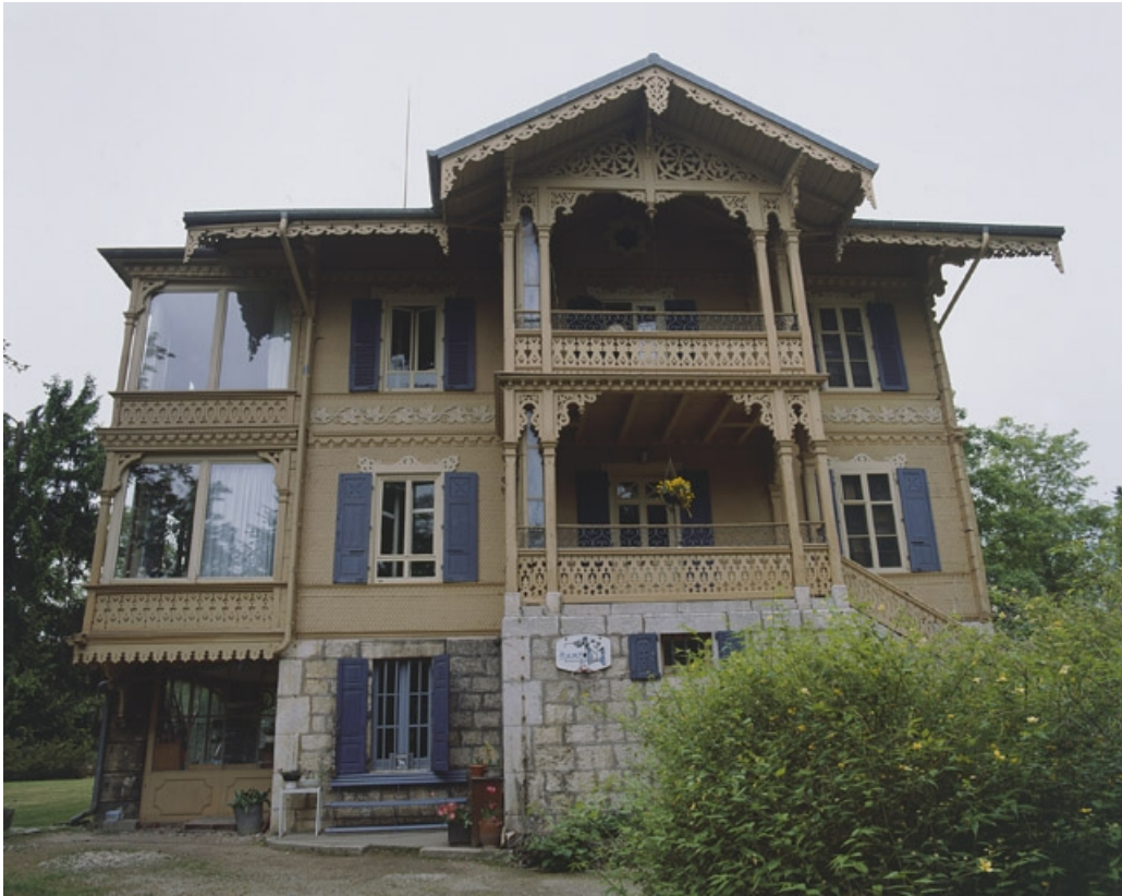
Chalet. Façade nord.
