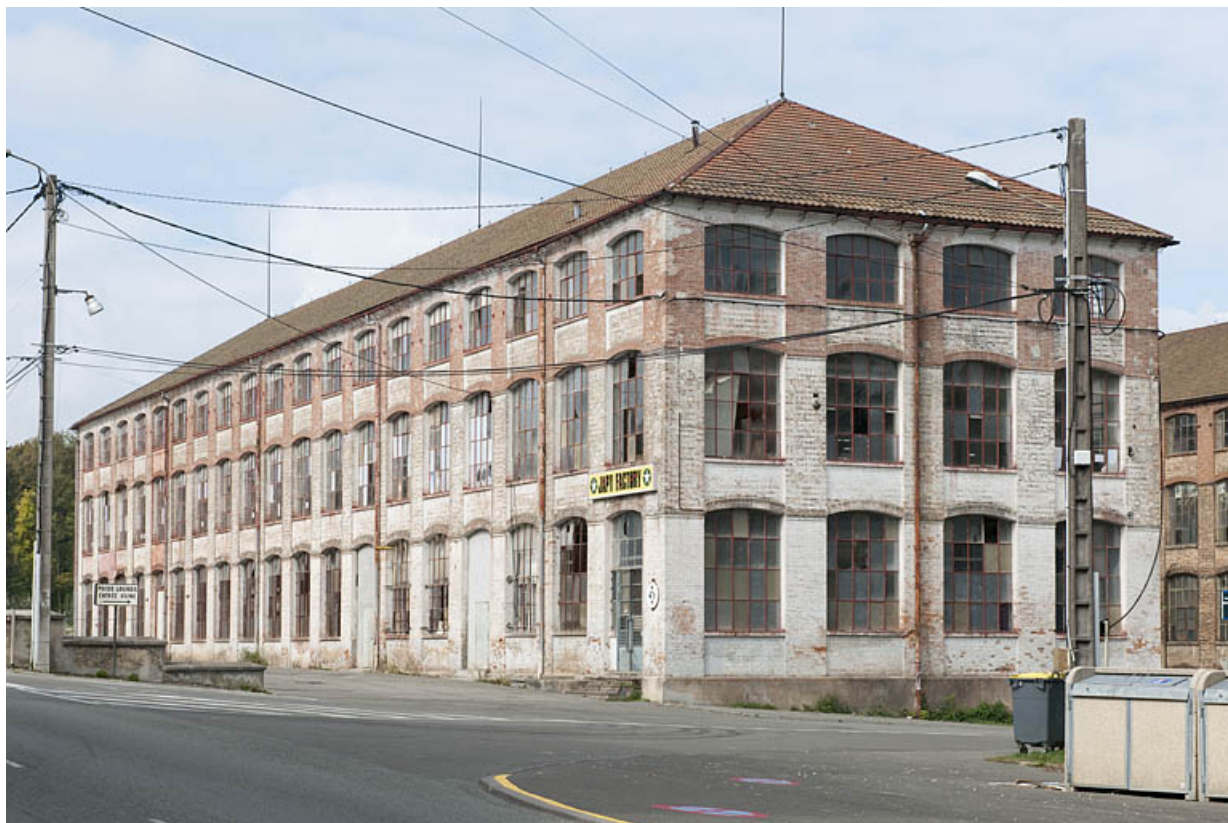
Vue d'ensemble rapprochée depuis le sud-est.
