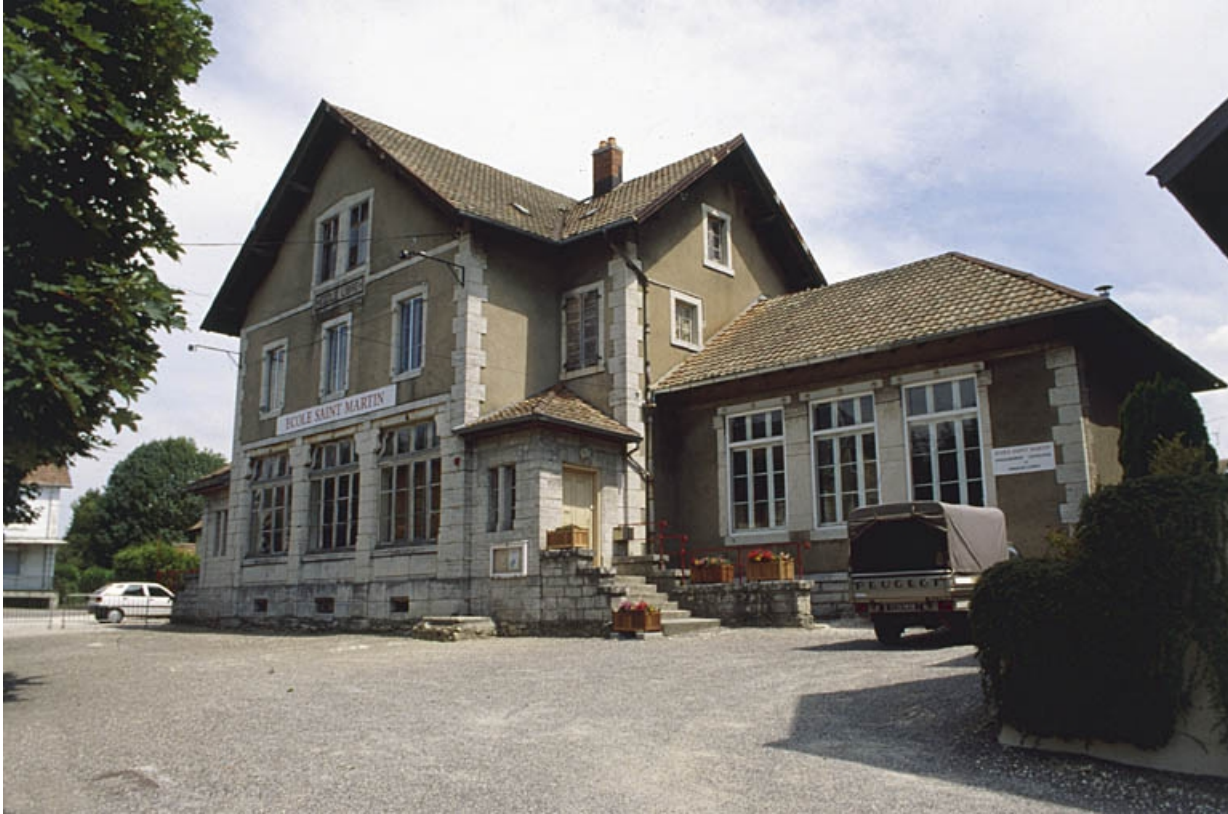
Façade antérieure depuis l'ouest.
