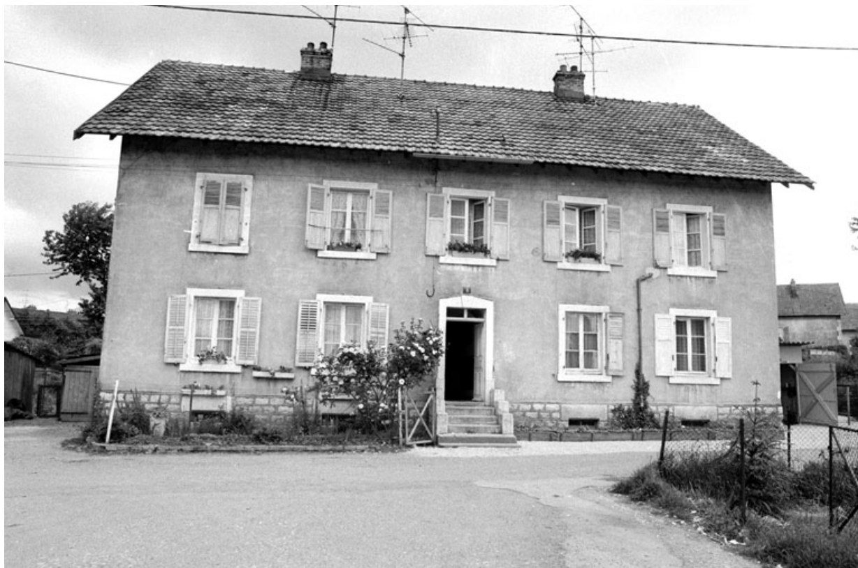
Maison ouvrière à quatre logements en 1980.
