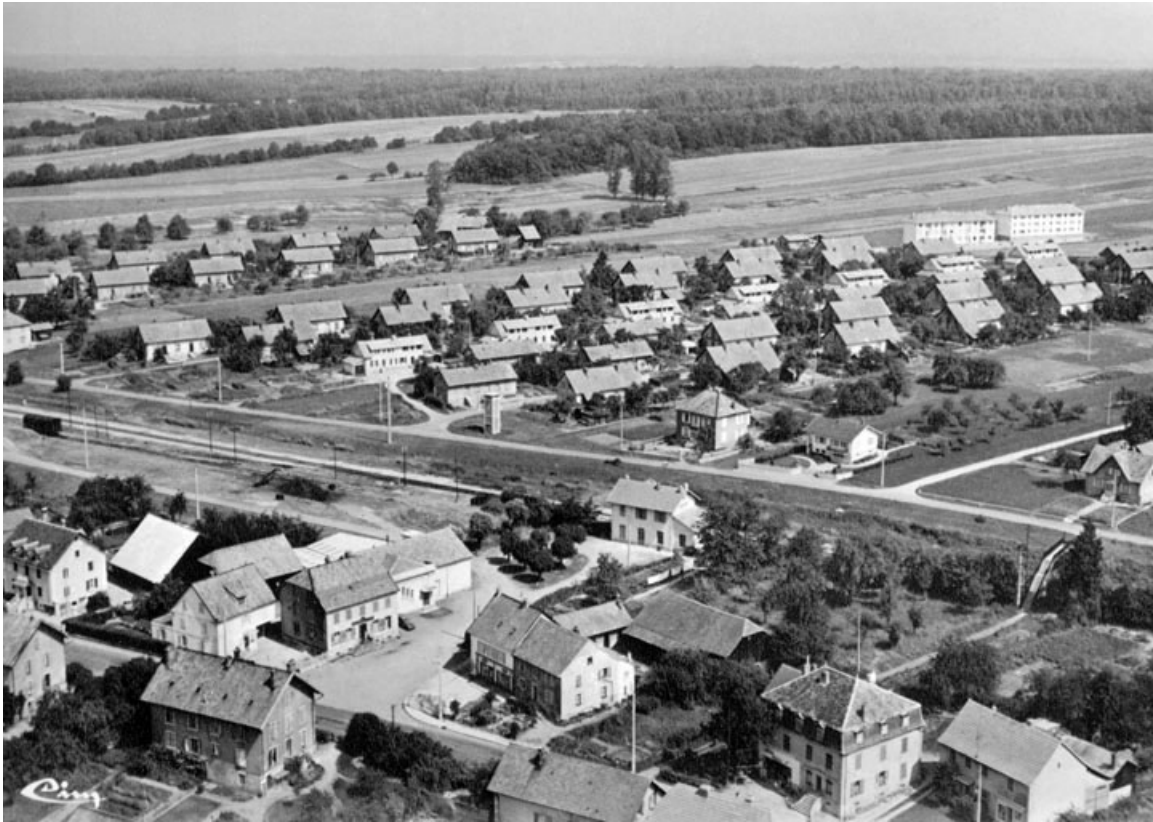
Grandvillars (Ter.-de-Belfort.). Vue générale.
