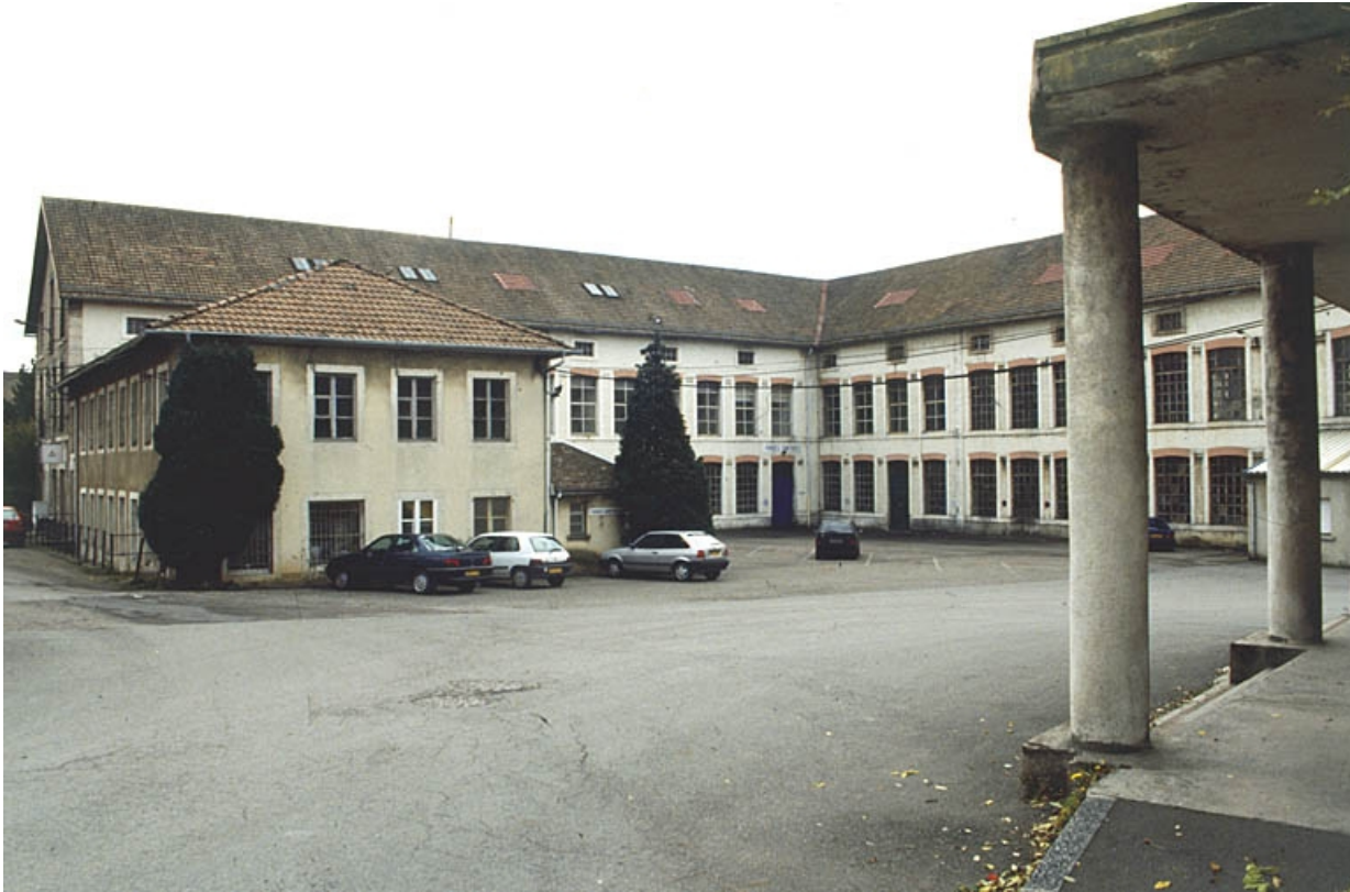
La cour de l'usine depuis l'entrée.
