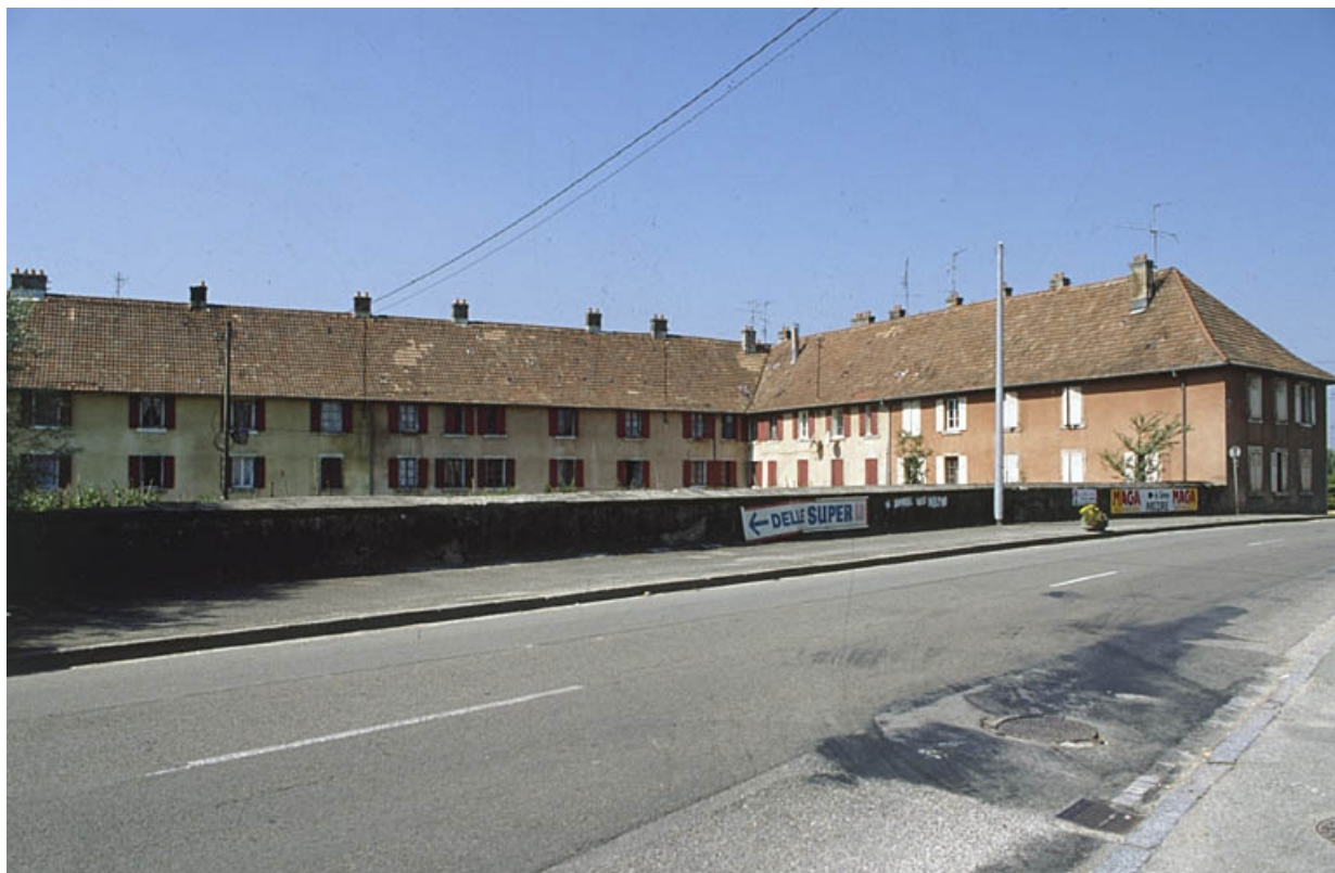
Logement ouvrier dit la Caserne depuis l'est.
