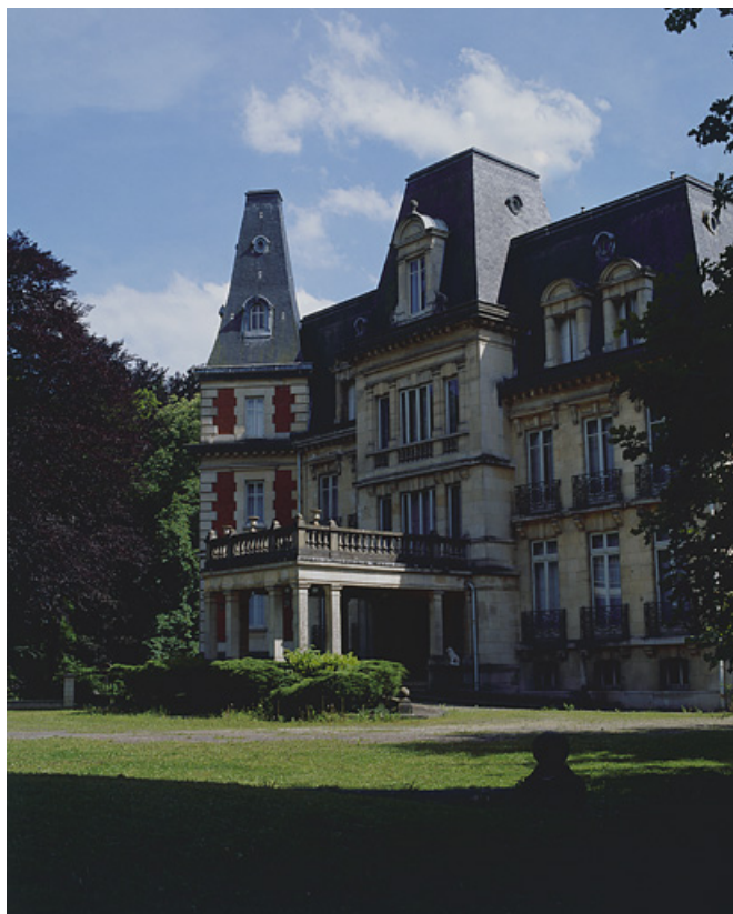
Façade nord vue de trois quarts.
