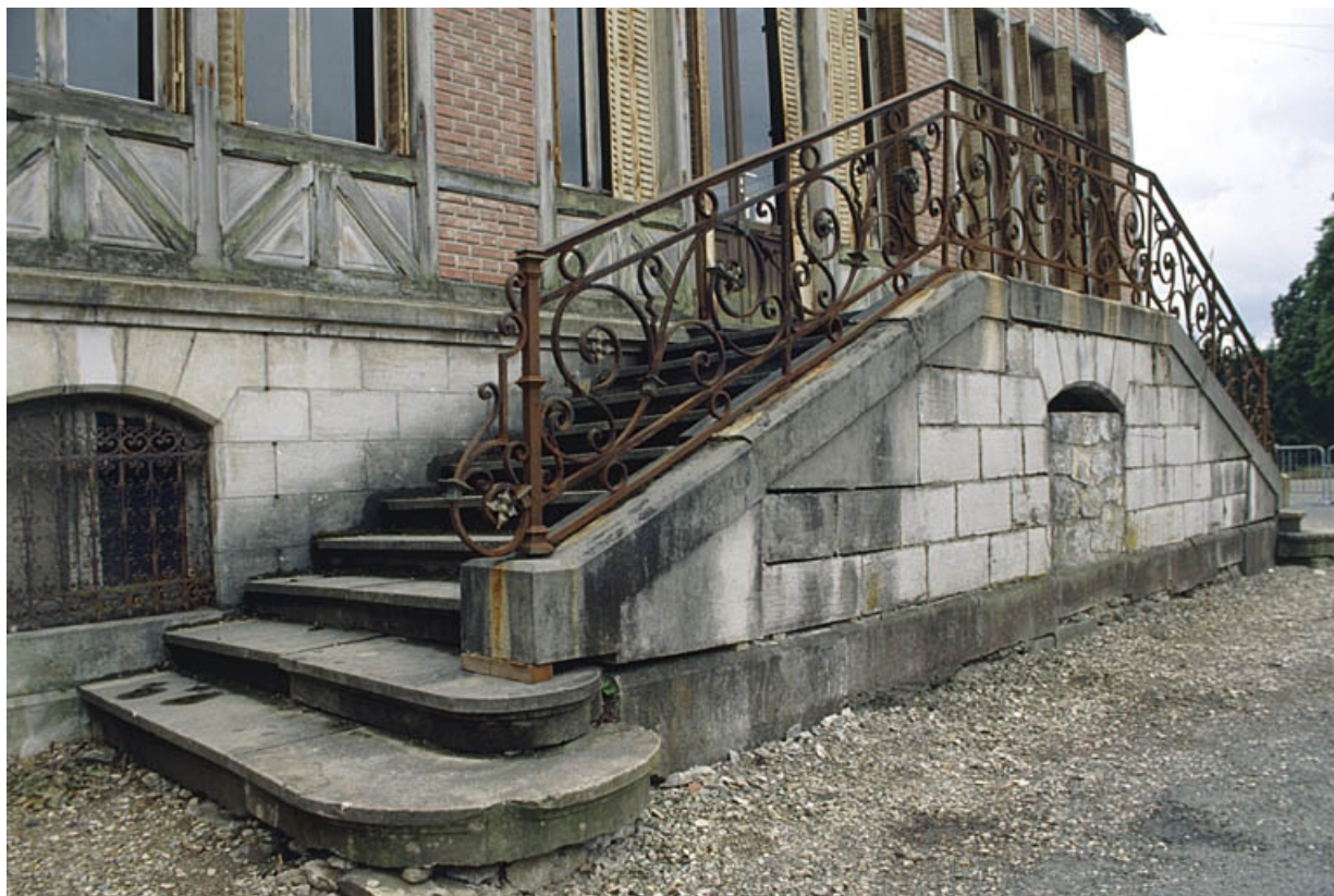
Détail de l'escalier de la façade postérieure.
