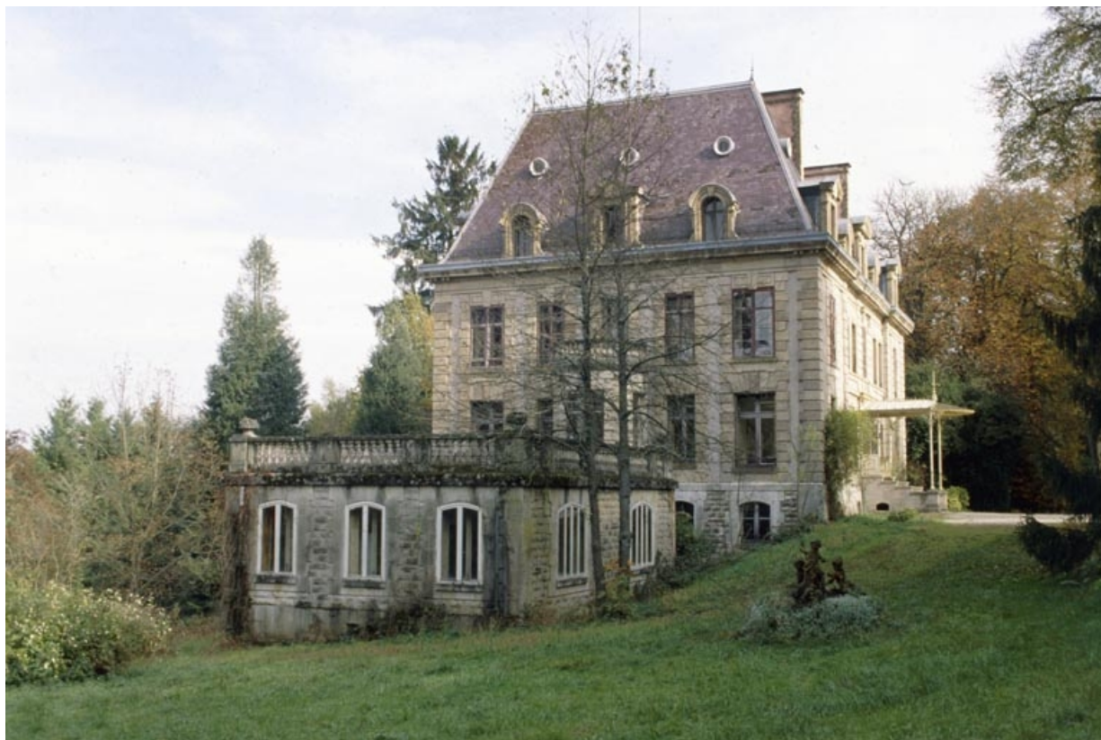
Vue depuis l'ouest.
