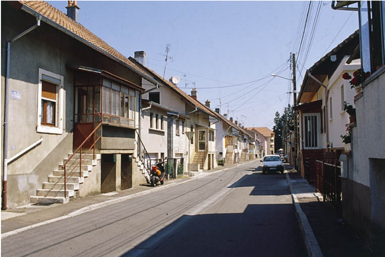
Logements ouvriers doubles rue du Commandant Prince.
