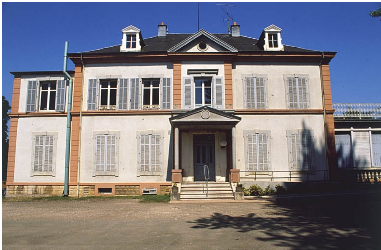
Façade est du logement patronal.
