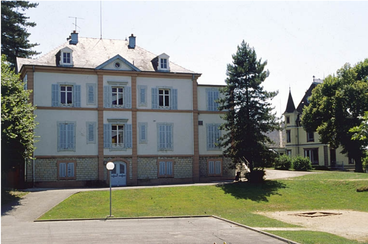
Façade ouest du logement patronal.
