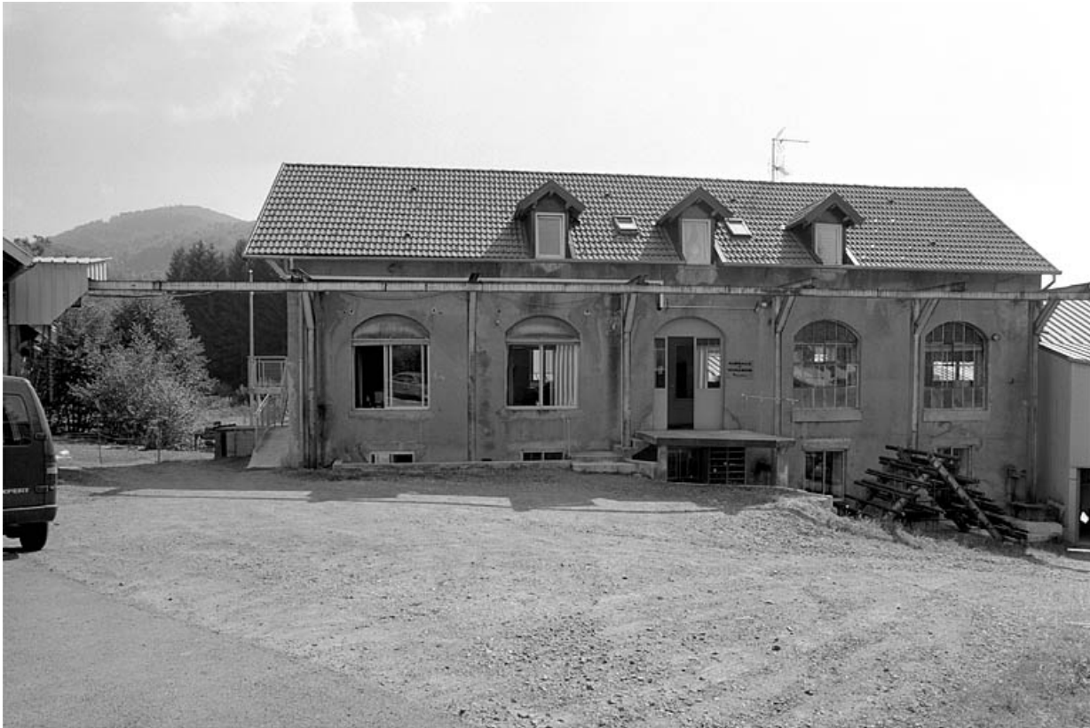
Façade ouest de l'atelier de fabrication primitif.
