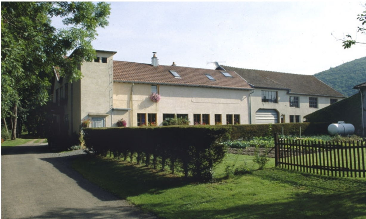
Atelier de fabrication nord depuis la rue.
