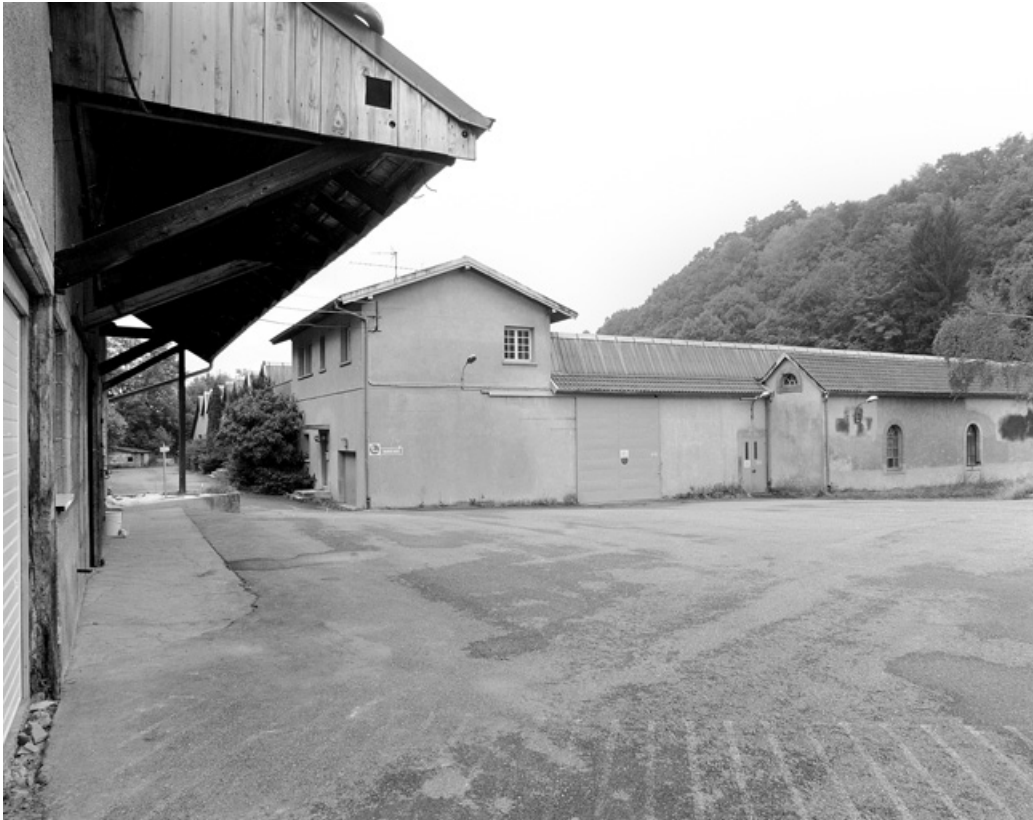
Bâtiments de la filature depuis le nord.
