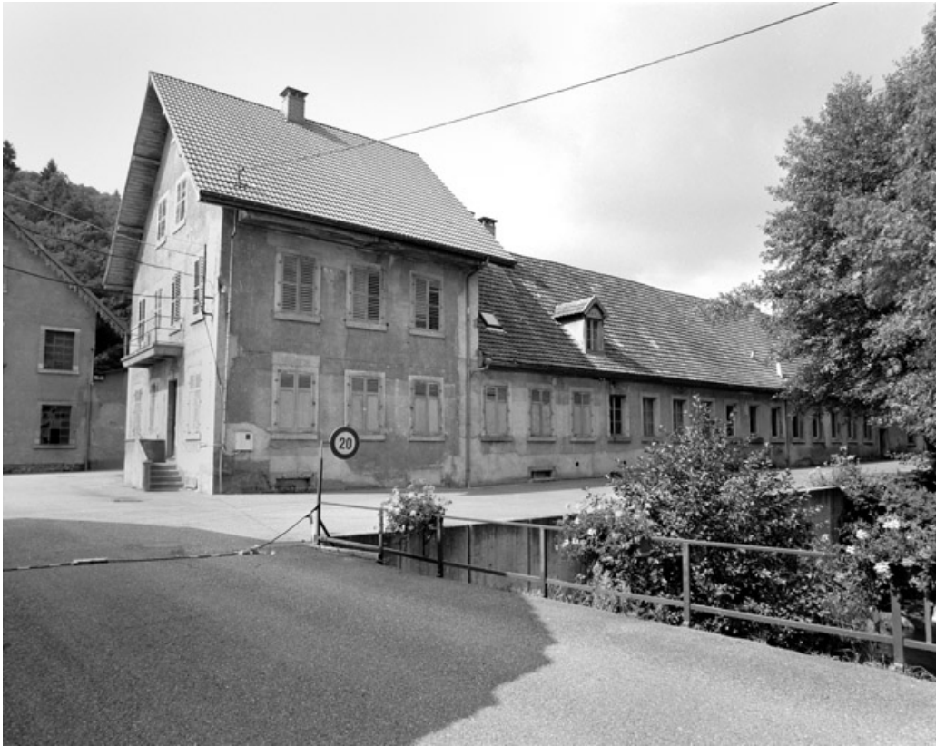
Bureaux et conciergerie depuis l'entrée.
