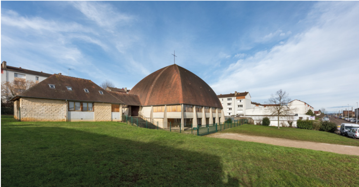
Centre paroissial. Vue d'ensemble de trois quarts.
