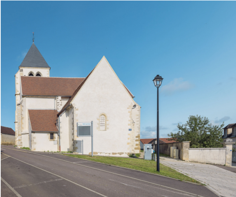
Vue d'ensemble depuis le chevet.
