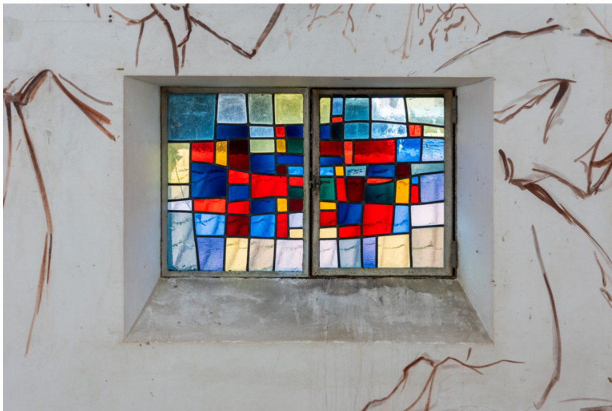
Vue d'une verrière (baie 5).
