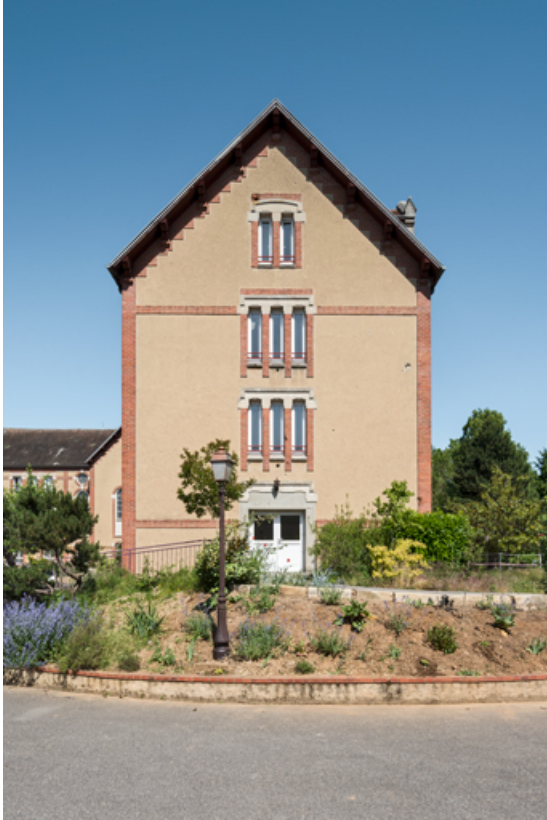
Vue du pignon ouest.
