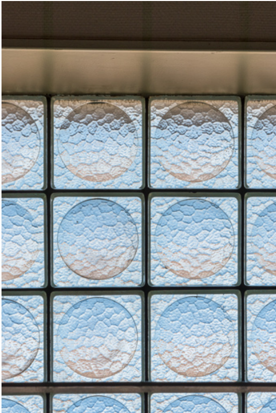
Cage d'escalier : détail des pavés de verre.
