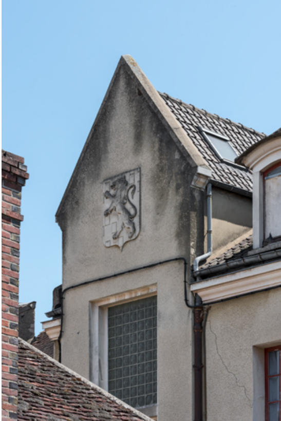
Pignon sculpté de la cage d'escalier.
