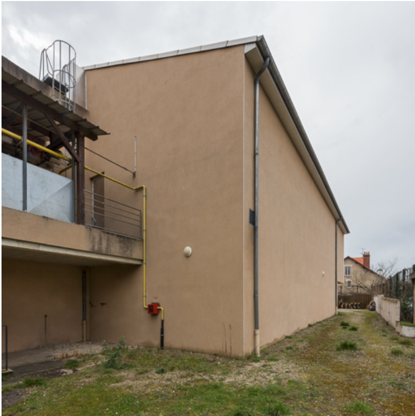
Salle 8, vue du nord.
