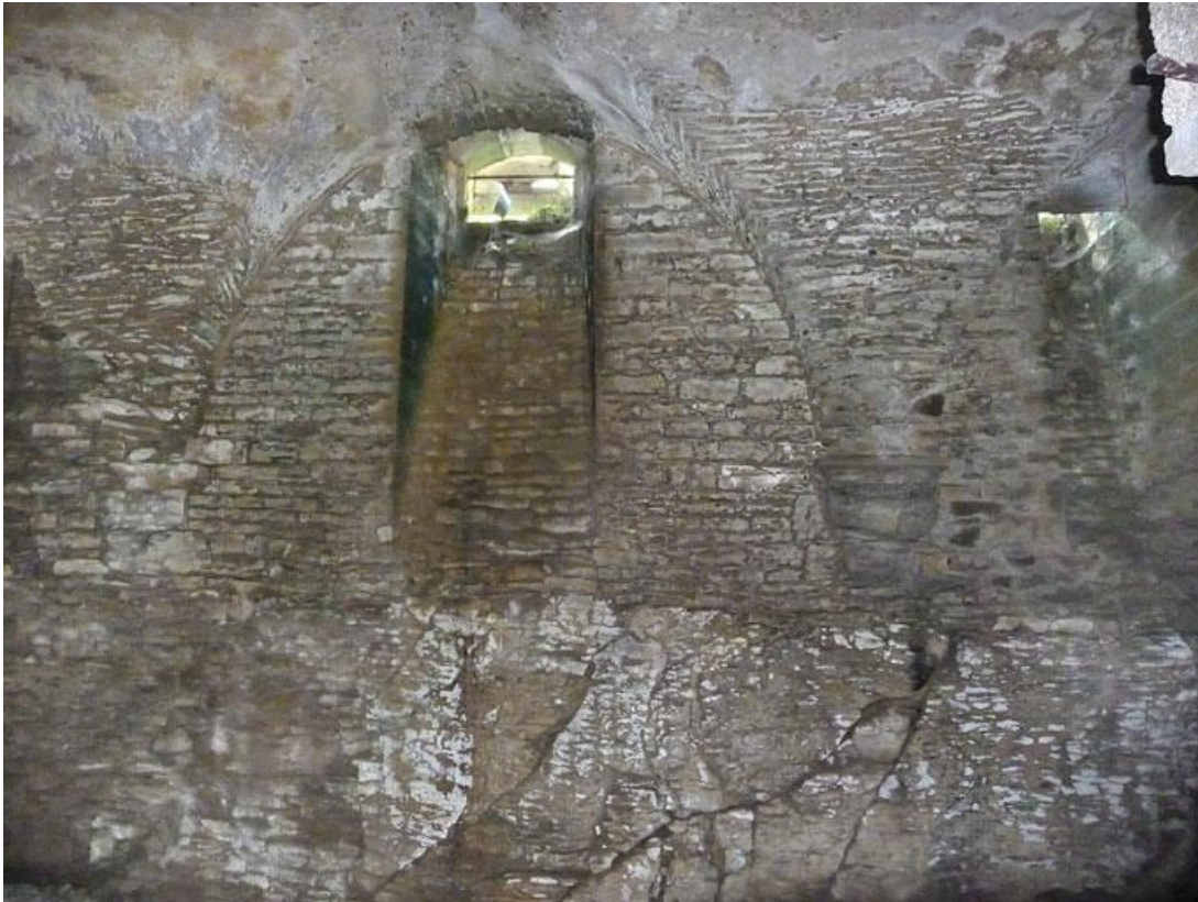
Cave sous la grange : soubassement rocheux, souterrain et culots.
