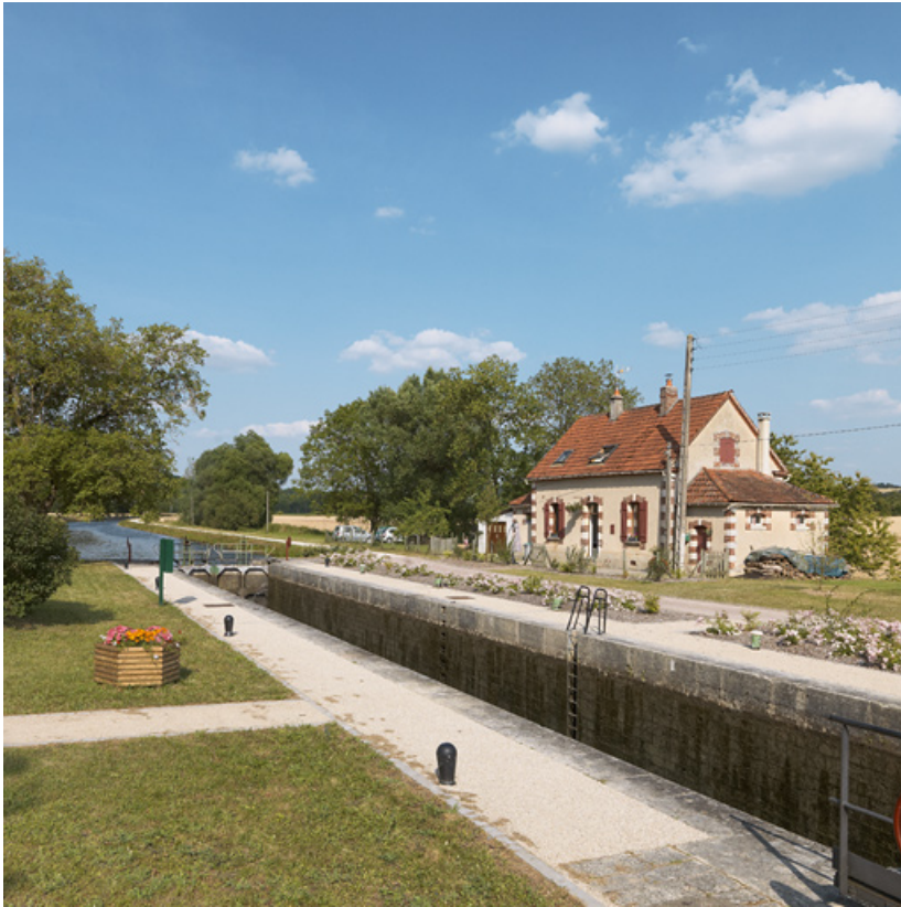
Vue d'aval du site d'écluse.
