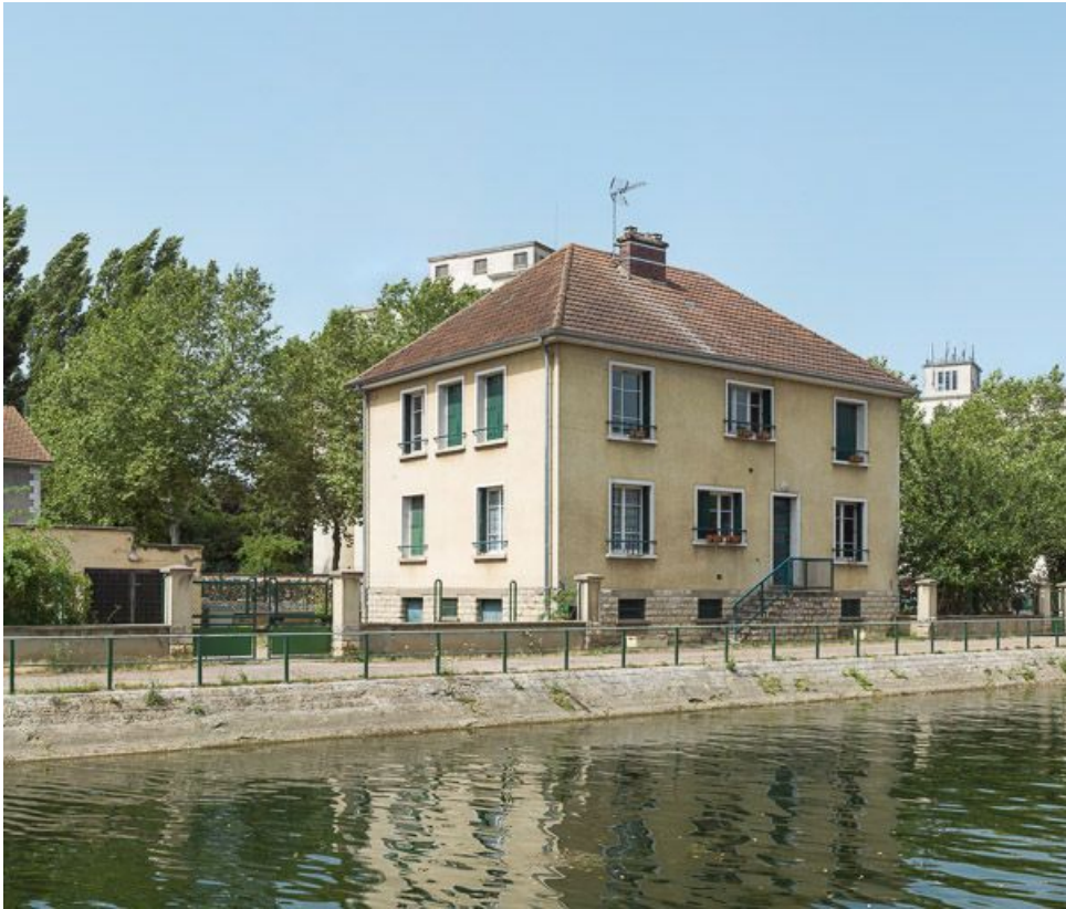
La maison éclusière, vue de 3/4.
