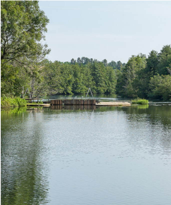
Vue d'ensemble du barrage à aiguilles.
