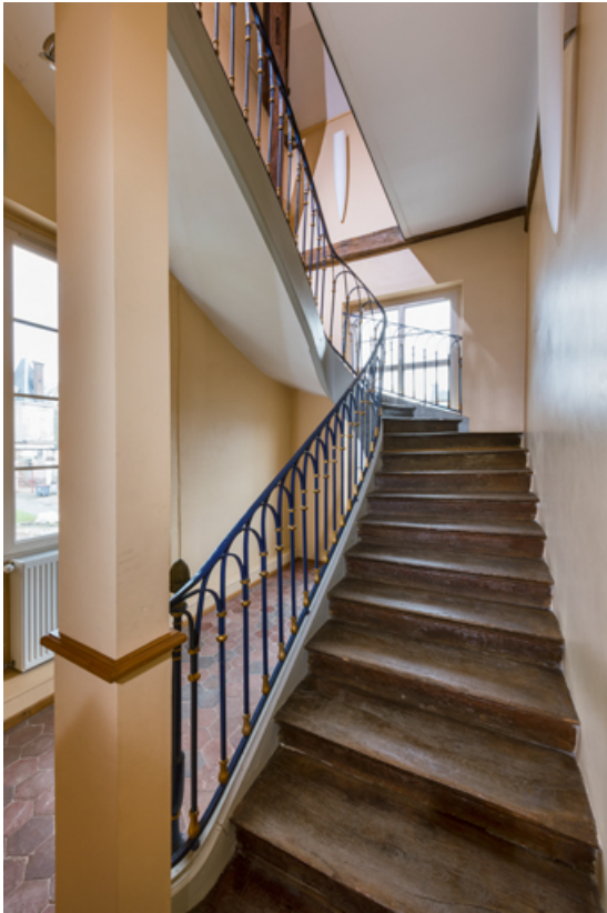
Escalier donnant accès à l'étage en surcroît.
