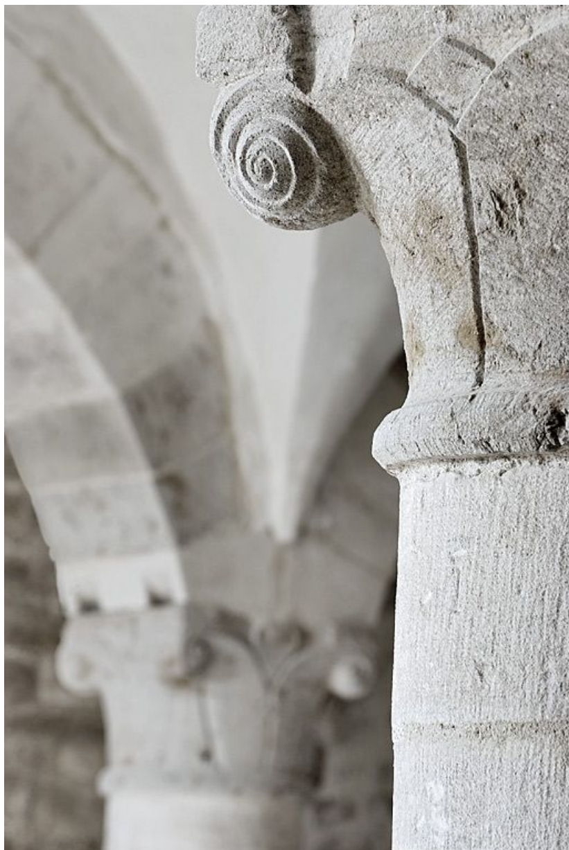
Salle voûtée, détail.
