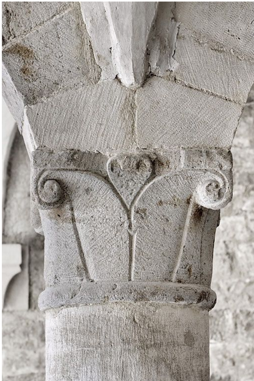
Salle voûtée, détail.
