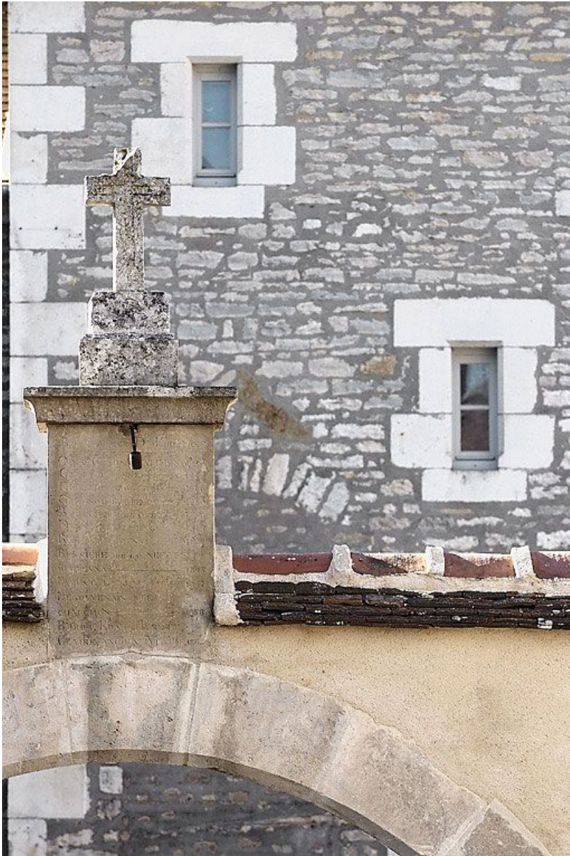
Détail de la croix surmontant le portail.
