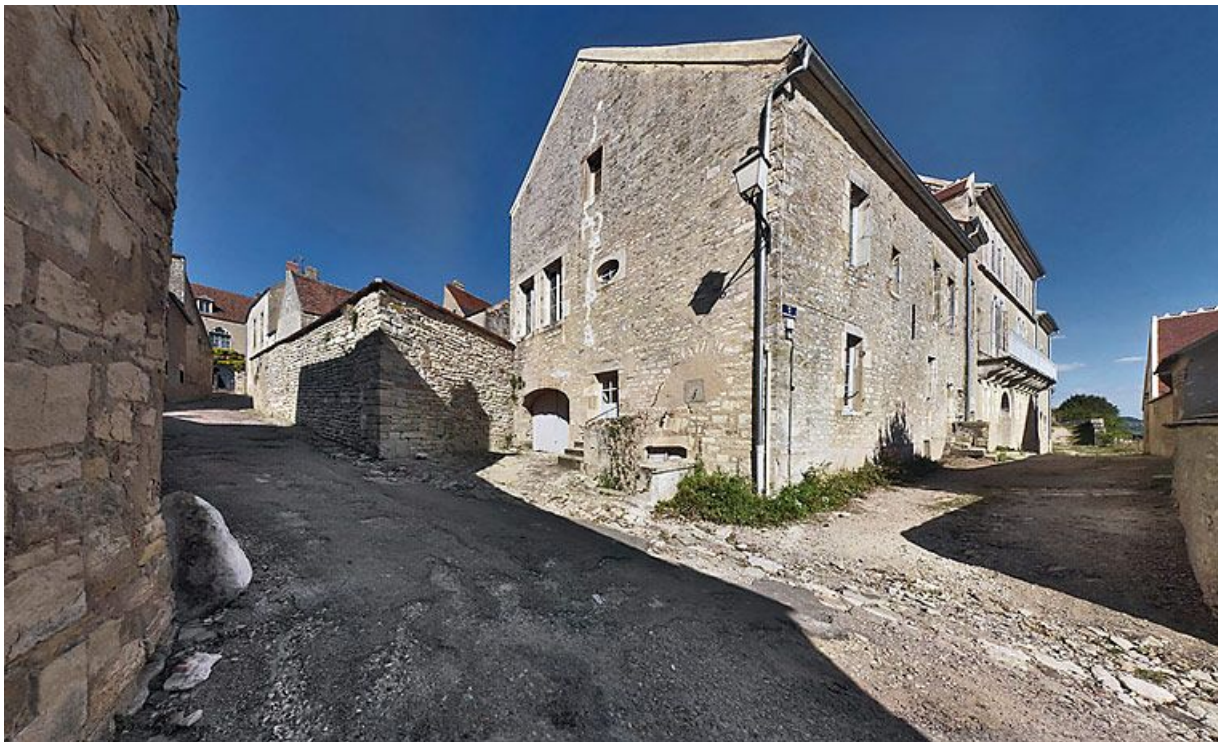
Vue d'ensemble des façades postérieures.
