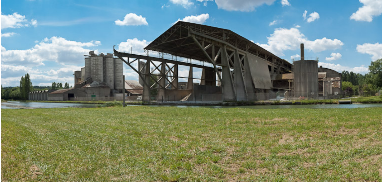
Vue du pont-roulant de la cimenterie.
