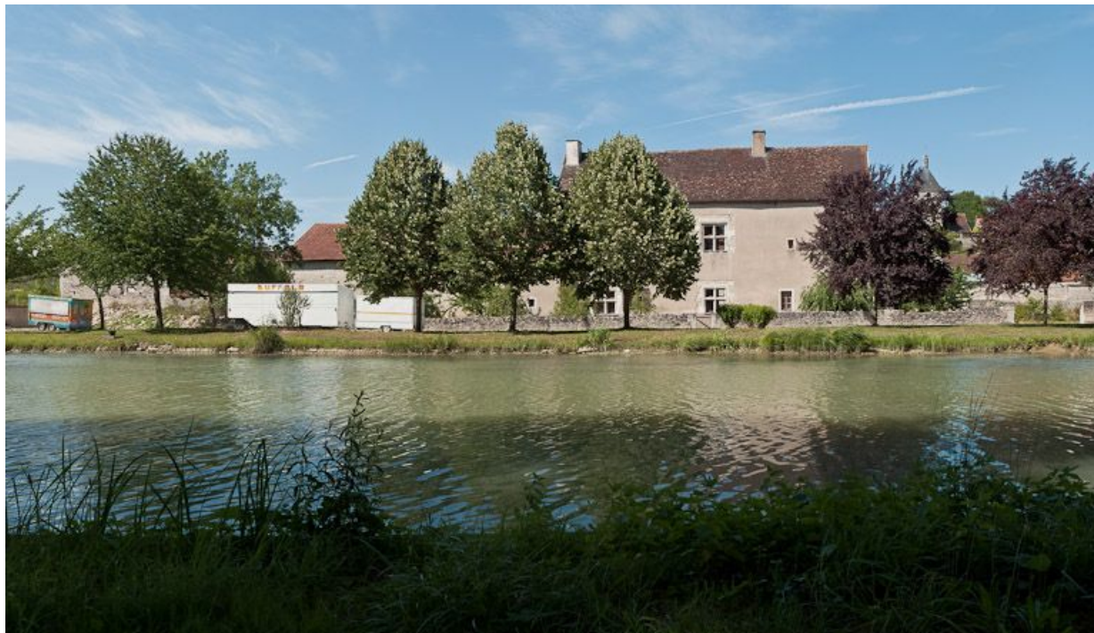
Vue d'ensemble du site depuis le canal.
