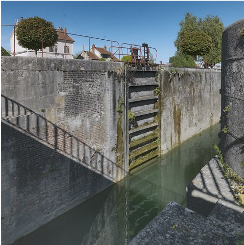
Site d'écluse vu d'amont : bajoyer en brique.
