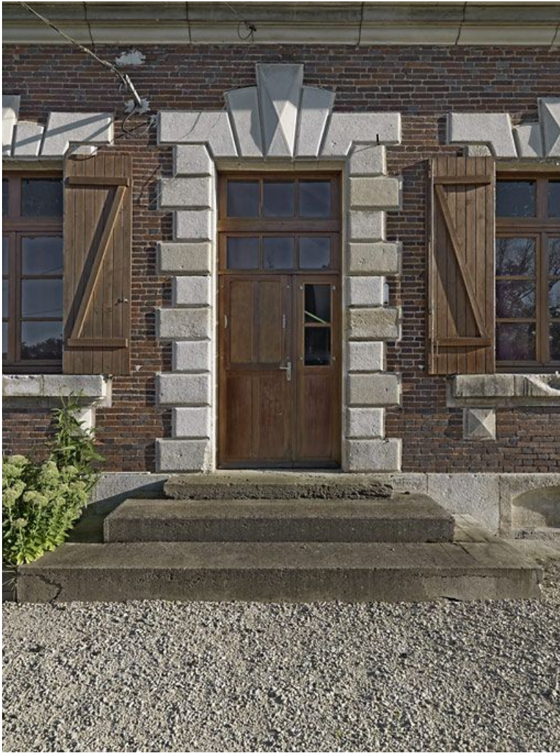
Maison éclusière : porte arrière.
