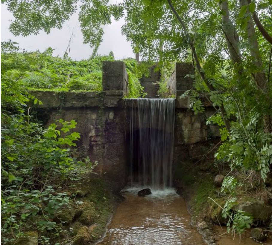
Vue de l'aqueduc et du déversoir.
