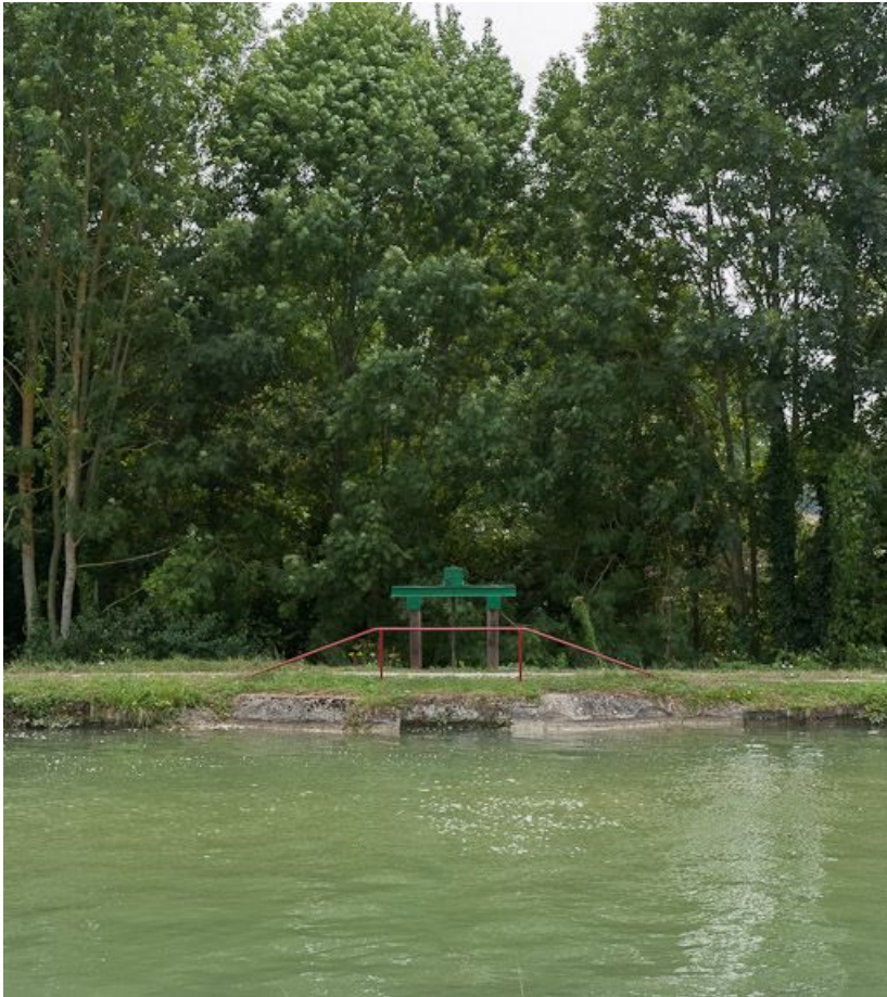
Vanne et déversoir vus du canal.
