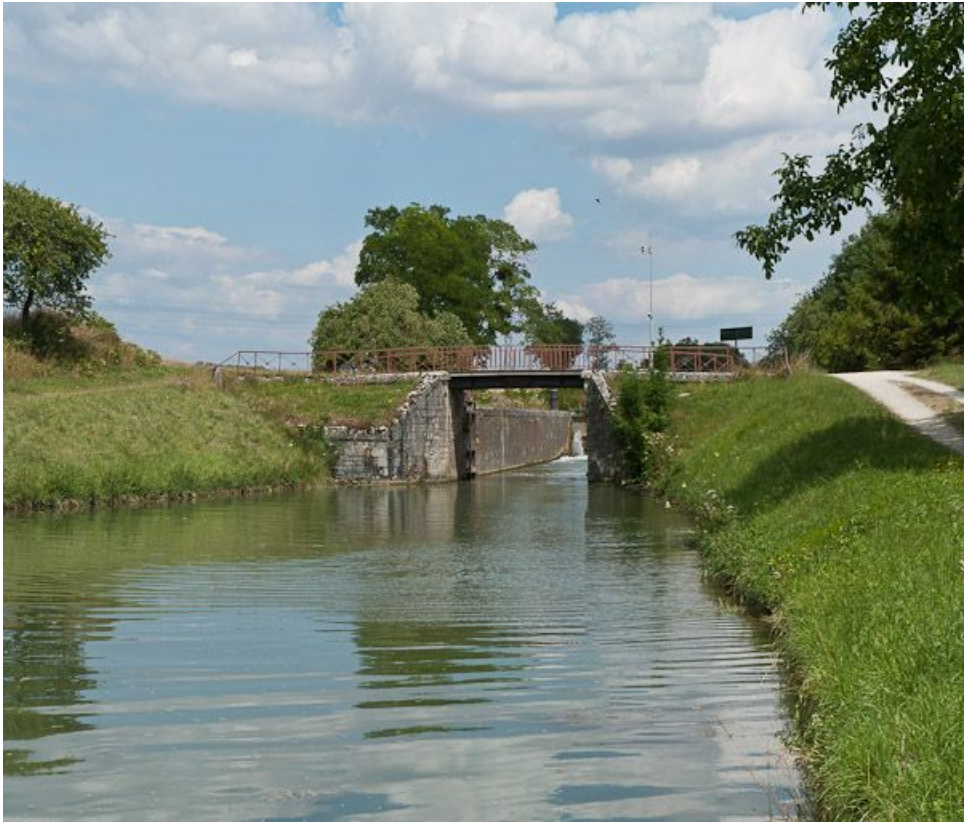
Vue du pont depuis l'aval.
