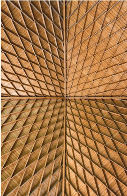
Charpente. Vue en contre-plongée.
