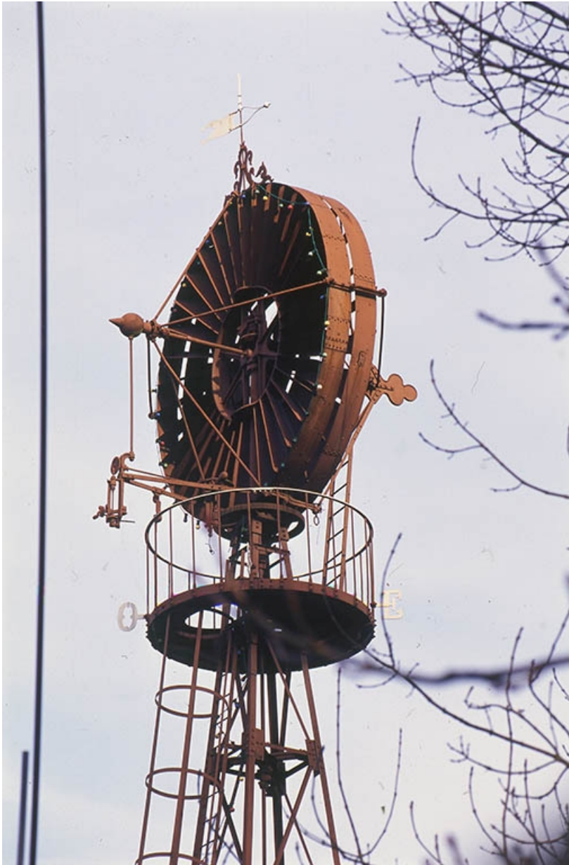
Détail : la passerelle sommitale et l'aéromoteur.
