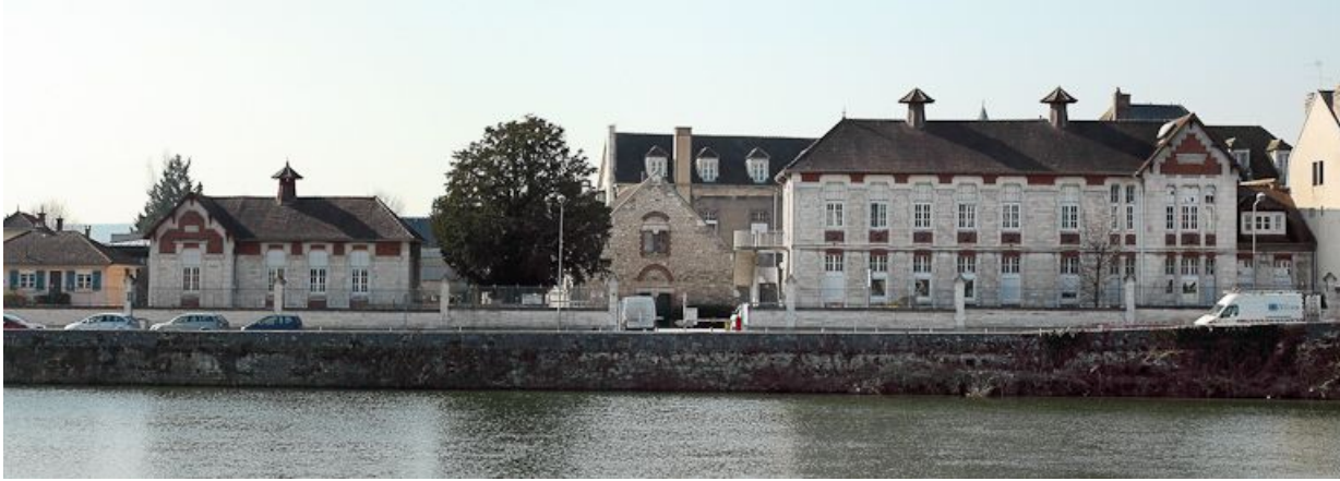
Bâtiments encadrant l'entrée de la cour.
