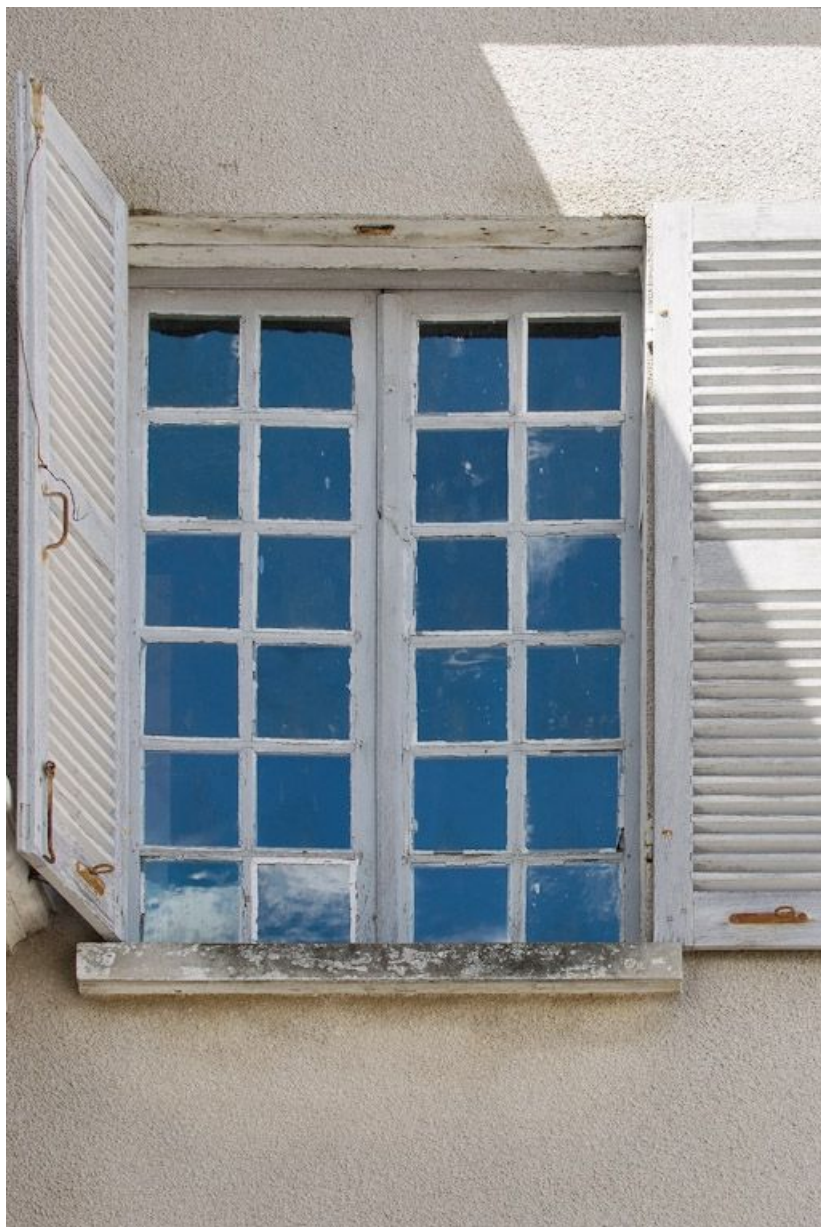
Bâtiment sud-ouest, détail d'une fenêtre.
