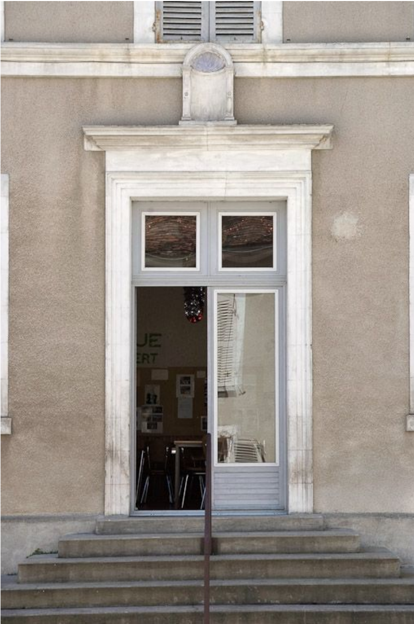
Bâtiment sud, porte d'entrée.
