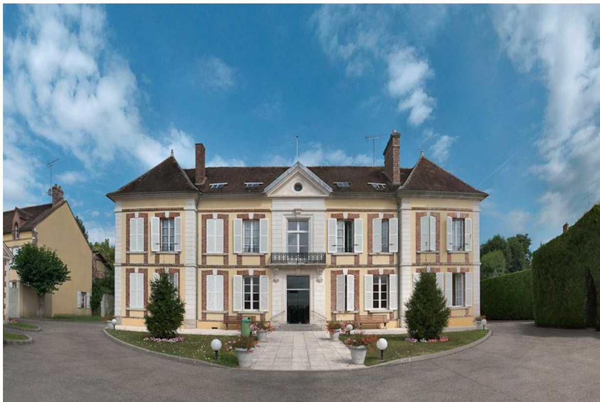
Vue d'ensemble : façade du bâtiment principal.
