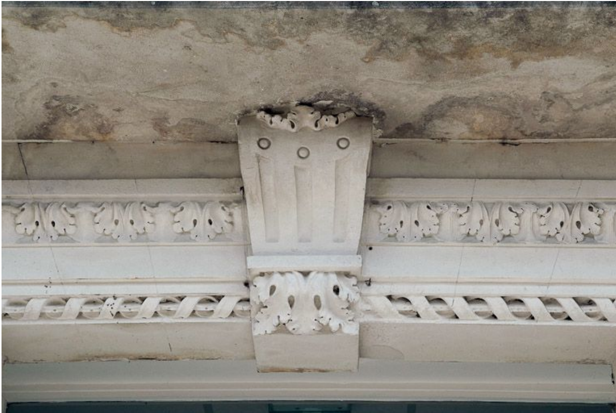
Bâtiment principal : agrafe de la porte d'entrée.
