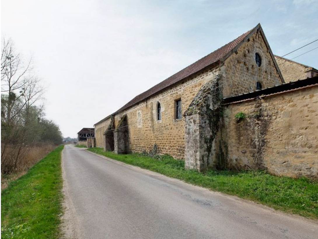
Chapelle, vue d'ensemble depuis la rue.
