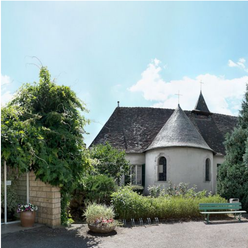
Bâtiment principal : abside de la chapelle.
