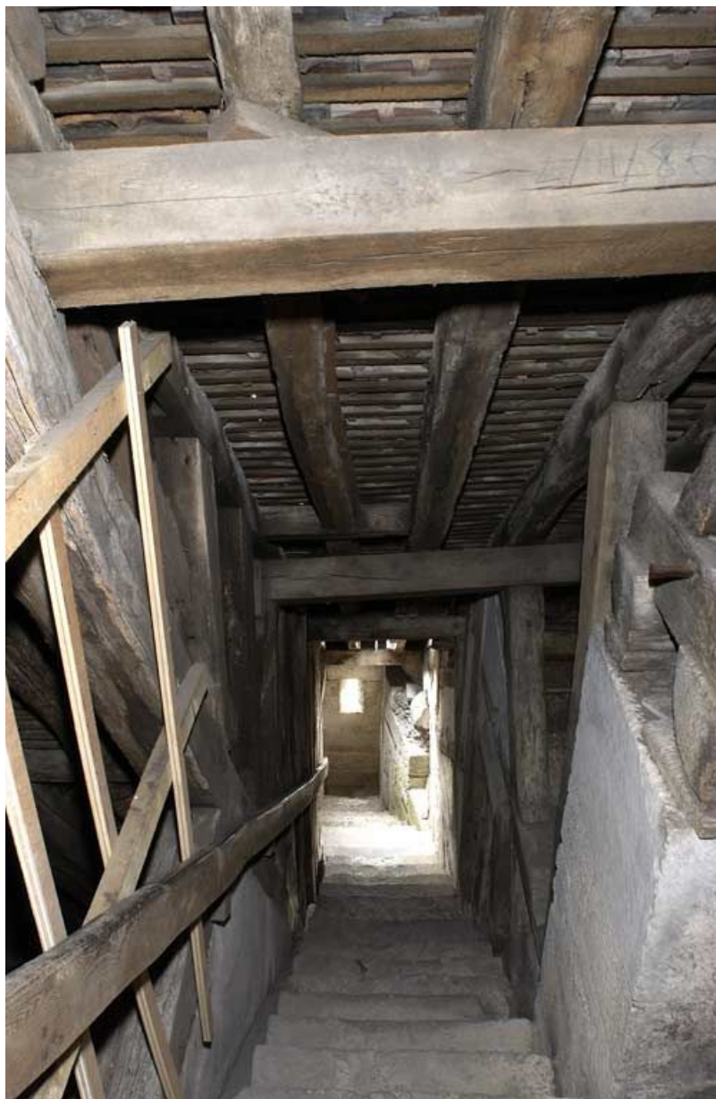
Montée d'escalier conduisant à la charpente.
