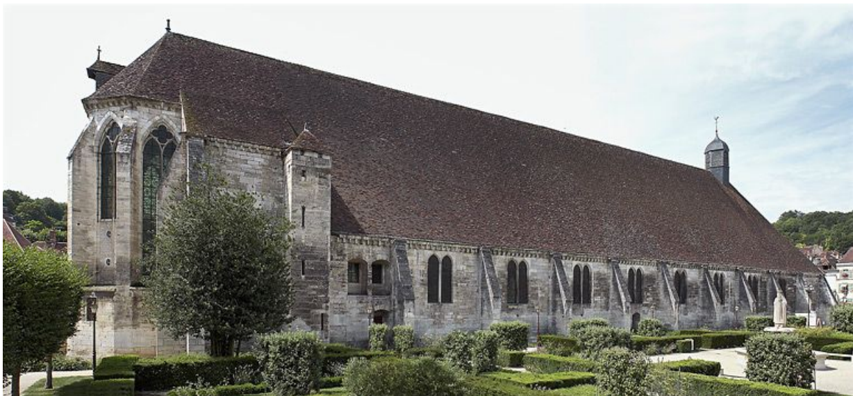
Vue d'ensemble de la façade nord.
