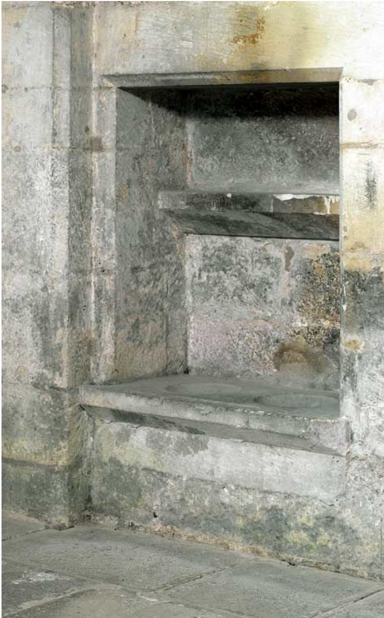
Lavabo de la chapelle latérale nord.
