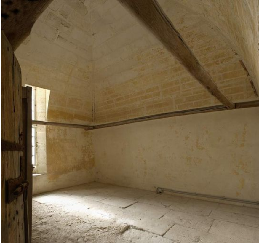
Vue intérieure de l'ancienne pièce des archives.
