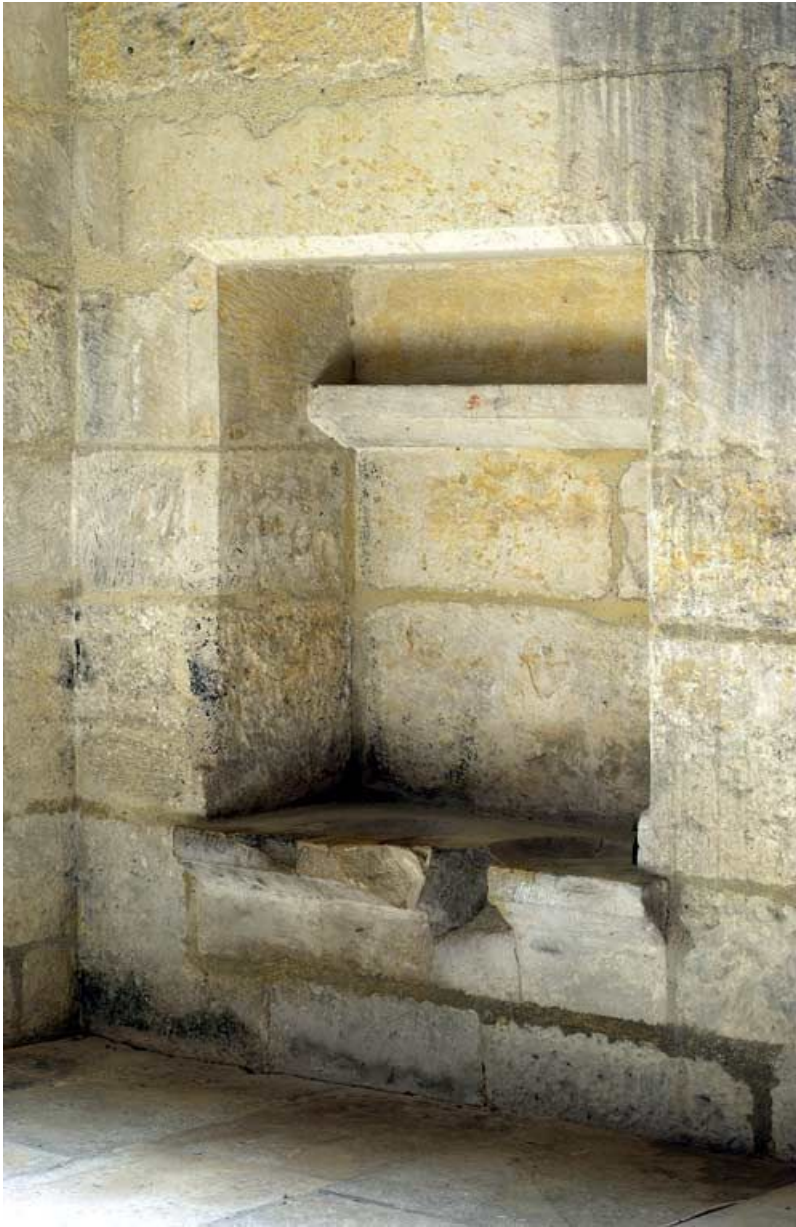
Lavabo de la chapelle latérale sud.
