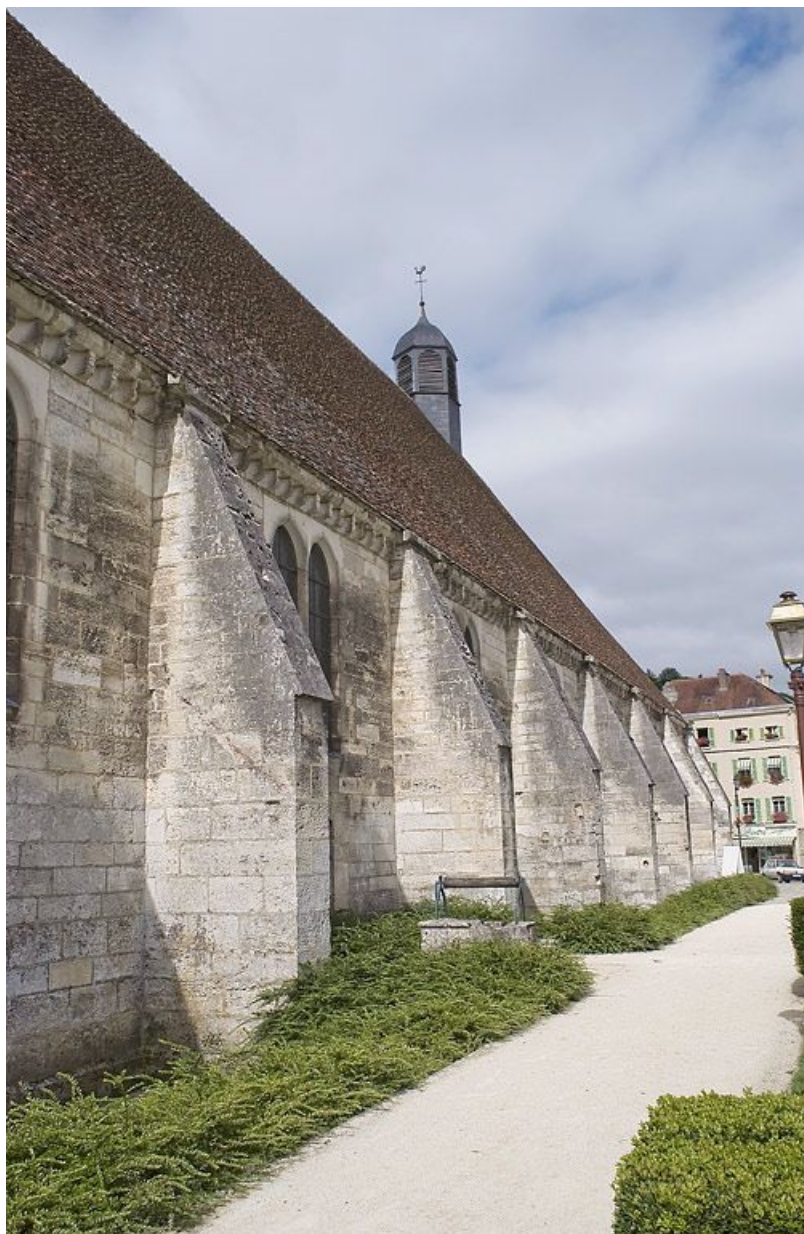
Vue des contreforts de la façade nord.
