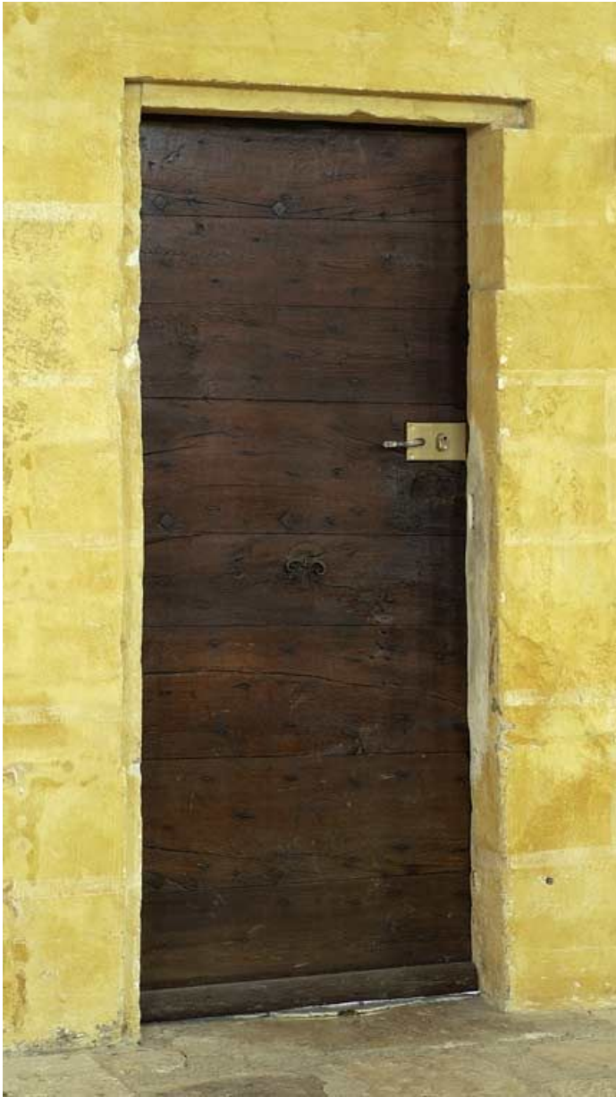
Porte donnant accès aux combles.
