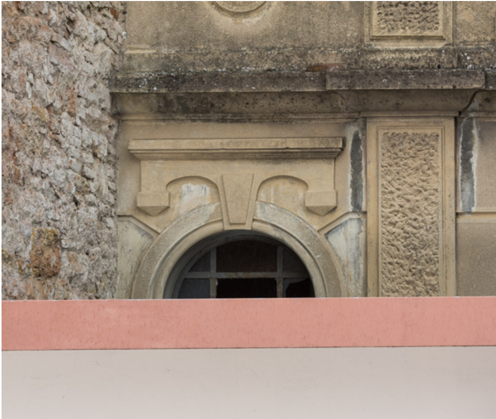
Façade antérieure : décor surmontant une fenêtre.
