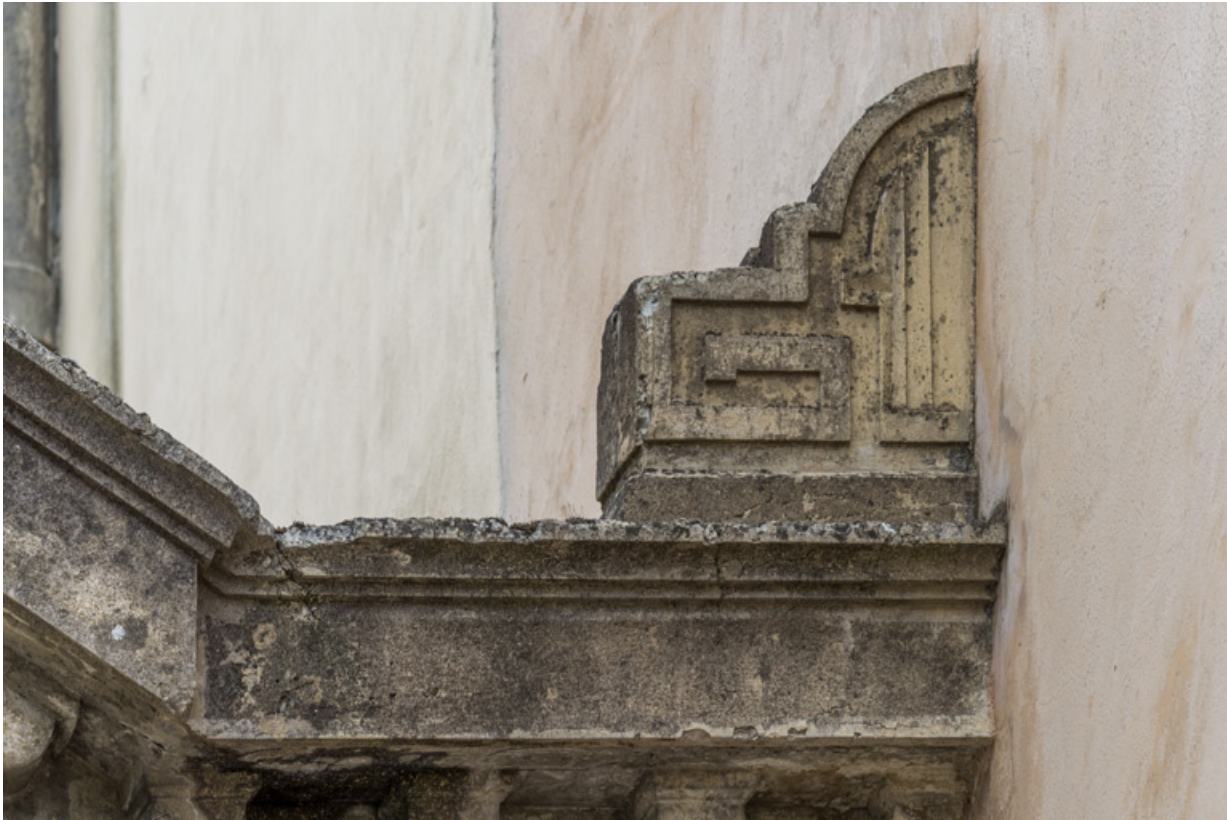
Façade antérieure : décor en partie supérieure.
