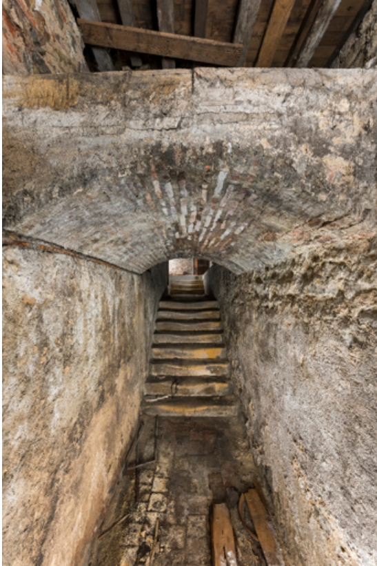
Couloir et escalier sous la salle.
