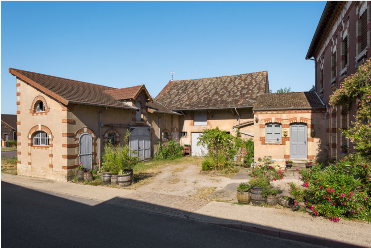
Etable, remise, fenil et cuisine.
