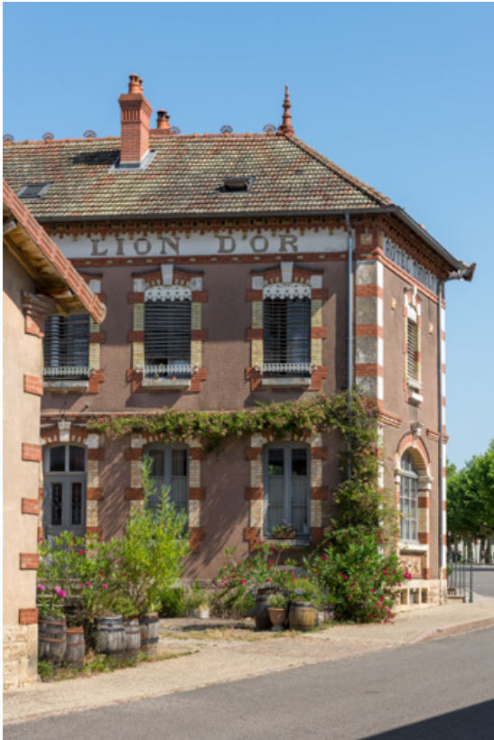
Hôtel-restaurant, vu du sud (vue rapprochée).
