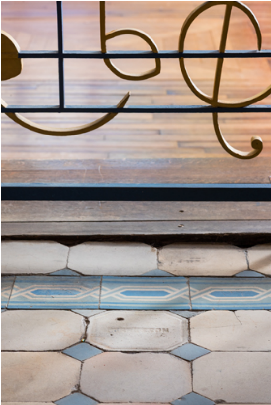
Salle de bal : sol de l'ancienne buvette.
