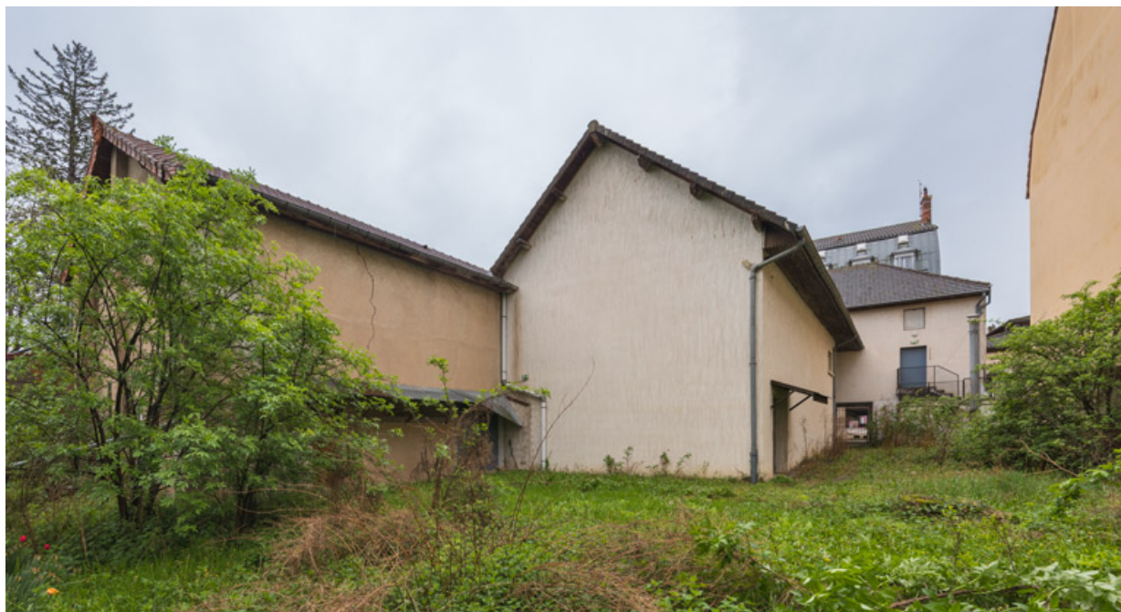
Façades postérieure et latérale gauche.
