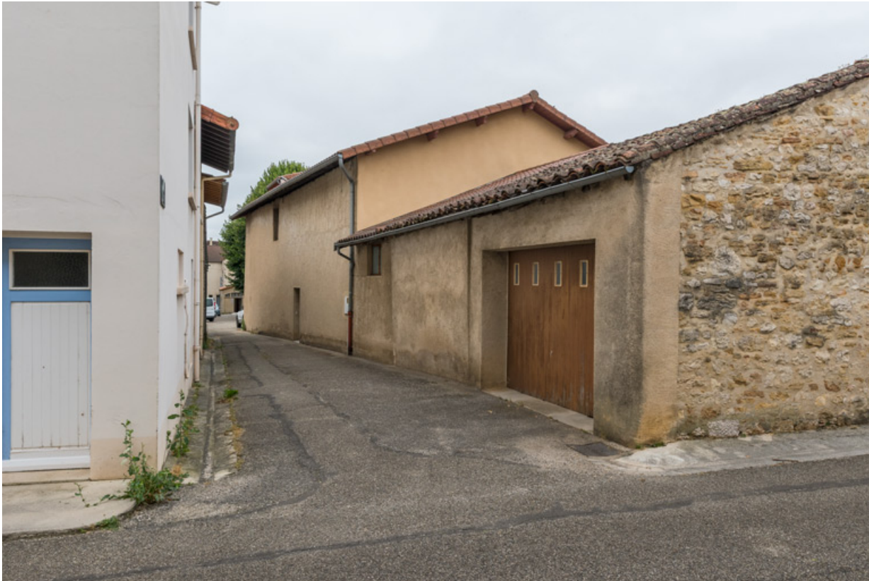
Façades postérieure et latérale droite.
