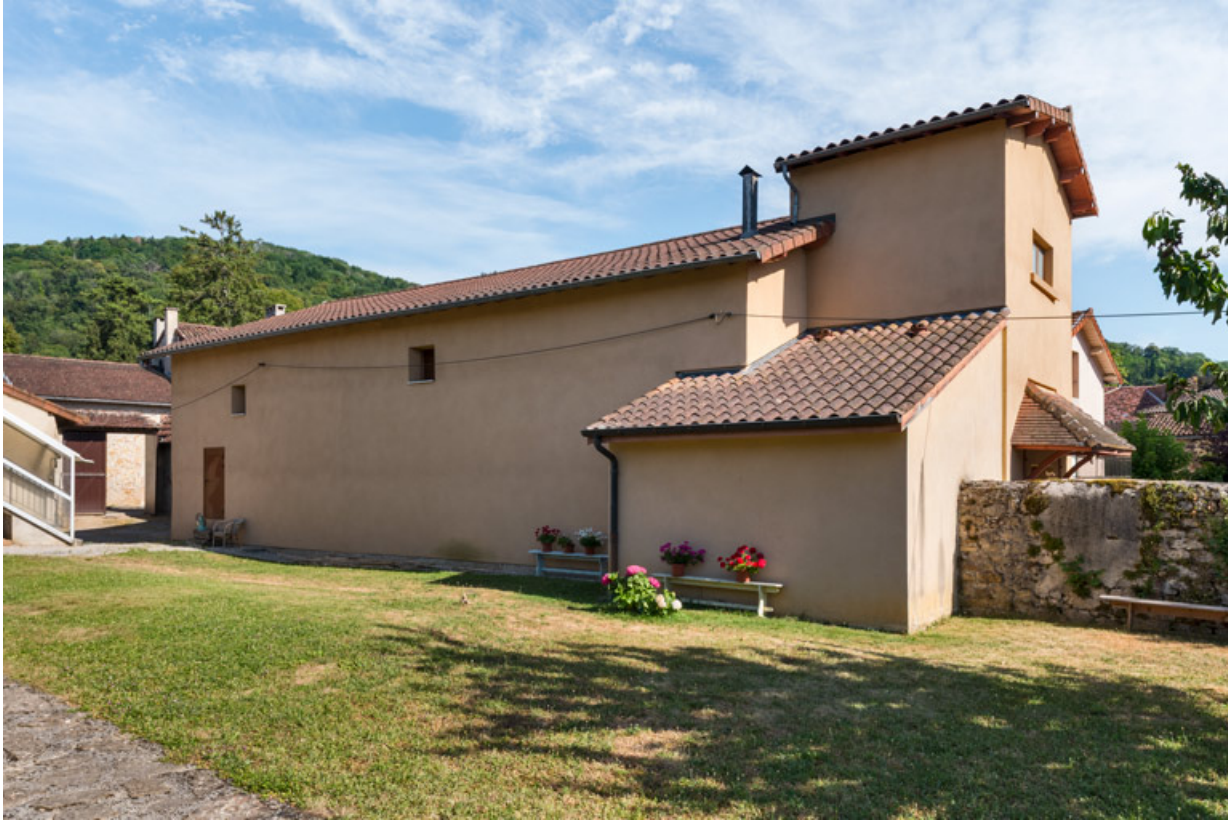
Façade latérale gauche, de trois quarts droite.
