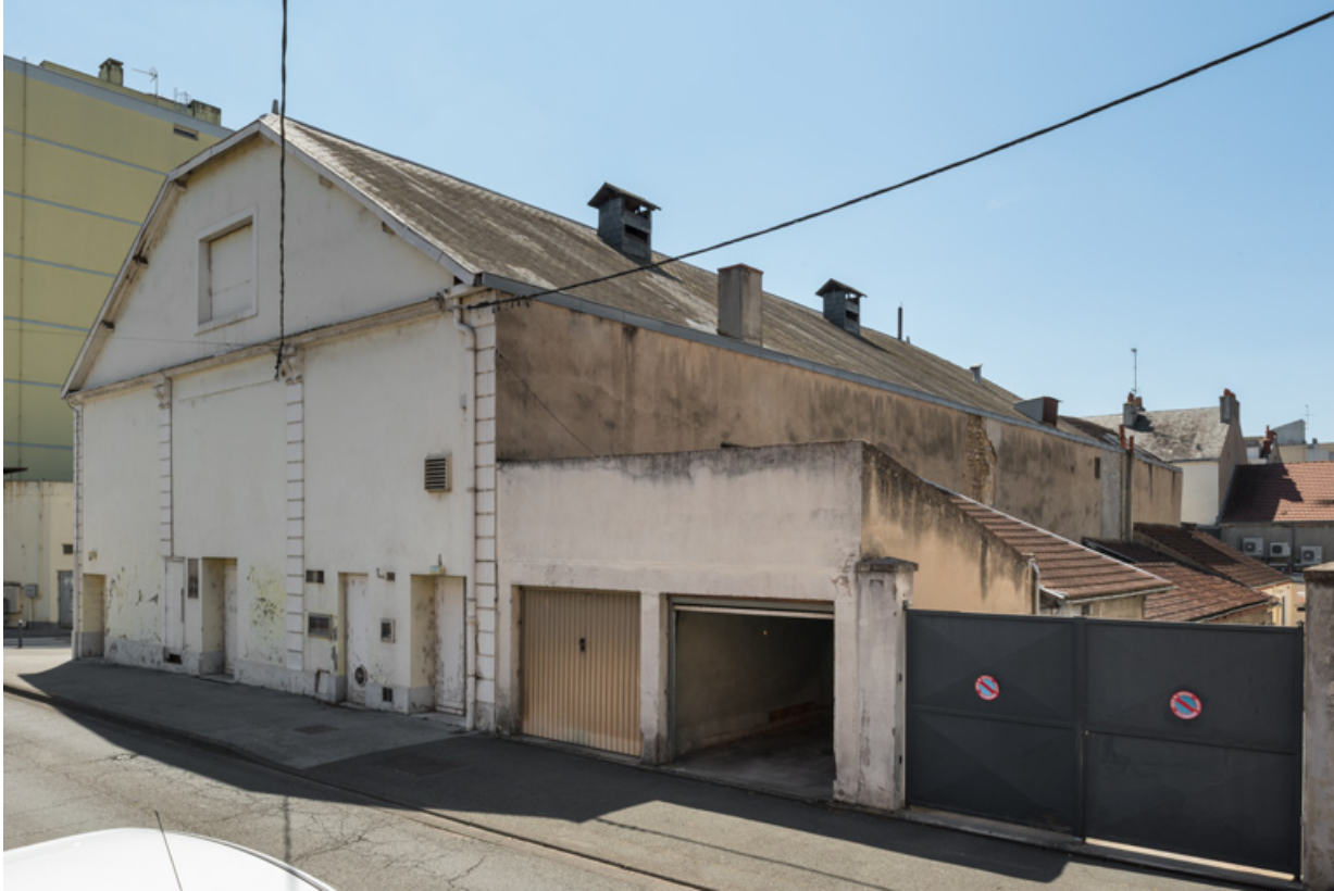
Cinéma : façades postérieure et latérale droite.
