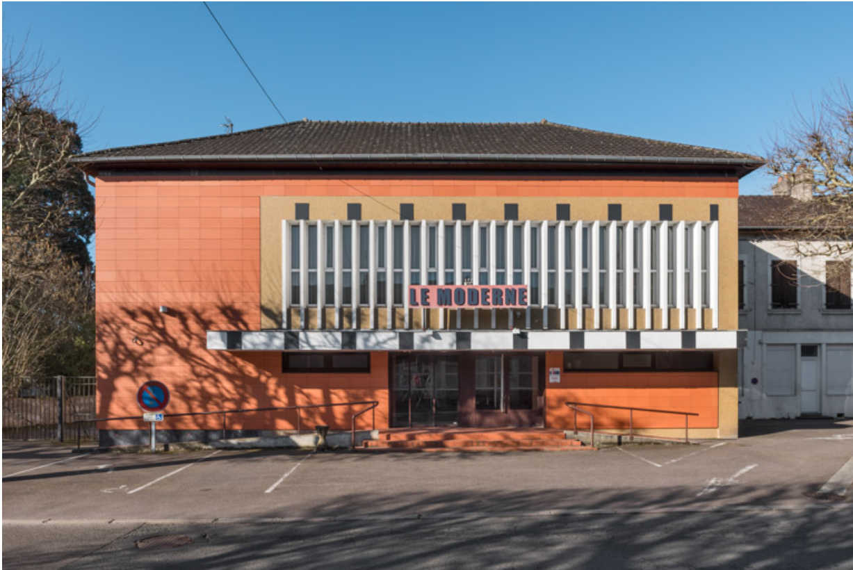
Corps d'entrée : façade antérieure.
