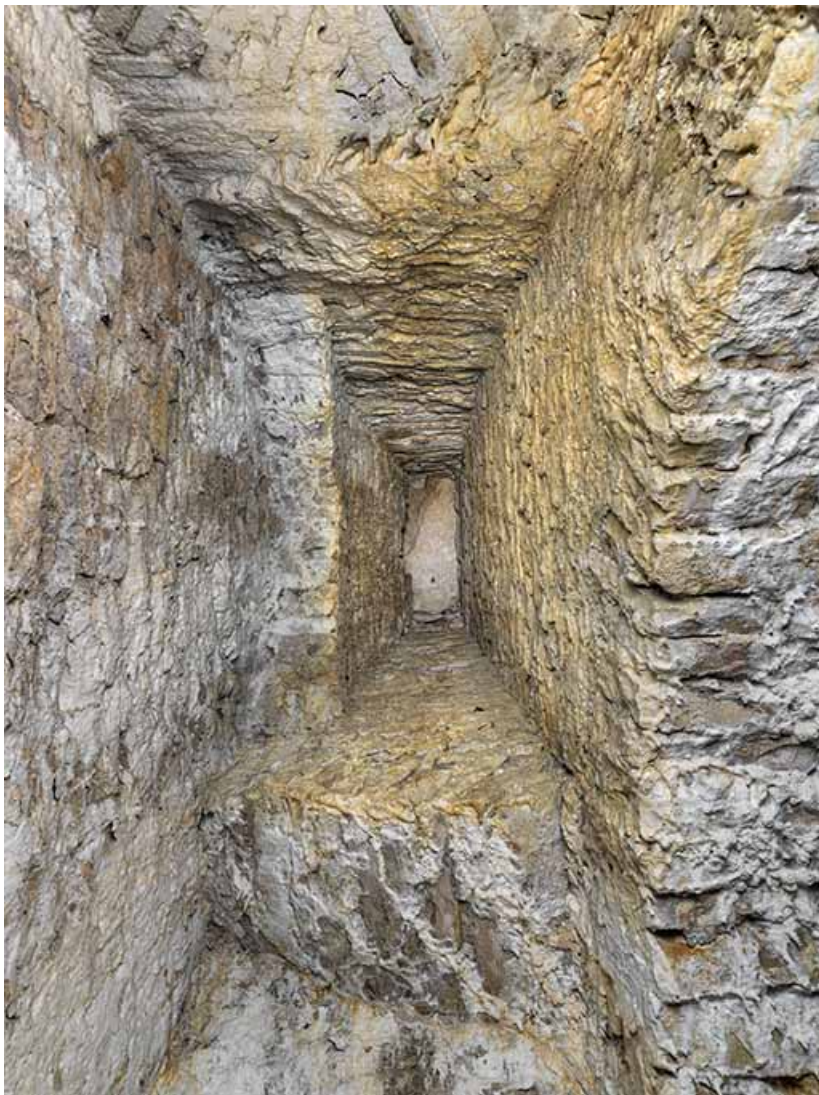
Hotte d'une cheminée.
