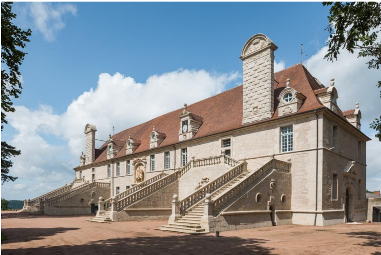
Façade sud-est, vue d'ensemble depuis l'est.
